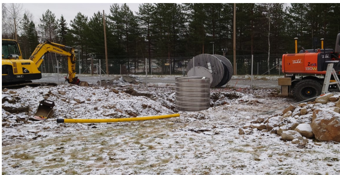
Kuva 10. Säävarman laitesuojan ja kompensointireaktorin asennus käynnissä Tampereen aikuiskoulutuskeskuksen Sähkökentällä. (Atte Saarni 2022)
