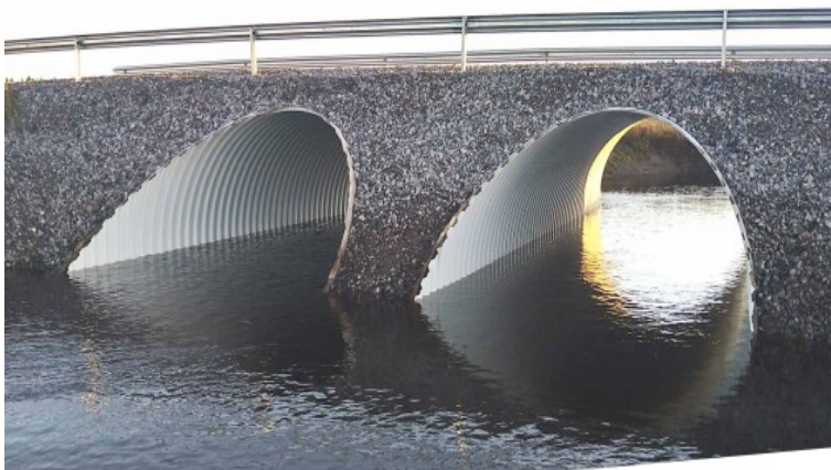
Kuva 5. Siltarumpuja kierresaumatusta putkesta. (Viacon 2023)
