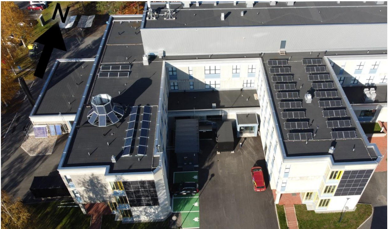
KUVA 9. Ilmakuva Oamkin hybridilaboratorioiden aurinkopaneeleista. Vasemmalla siipi 5A ja oikealla siipi 5B (OAMK 2020)
