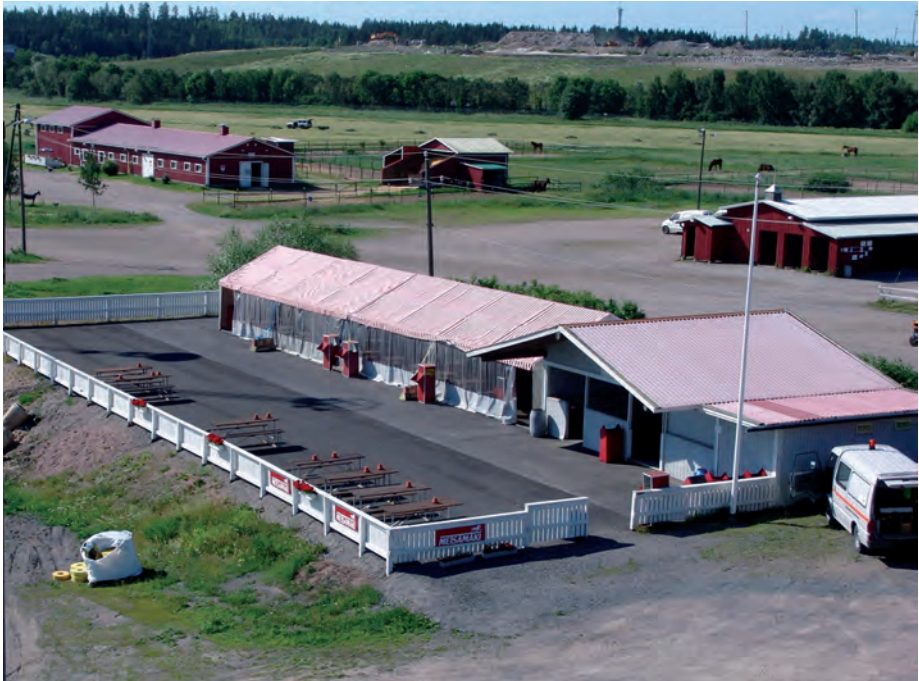
KUVA 4. Metsämäen raviradan alueen rakennuksia. (Kuva: Roger Johansson.)
