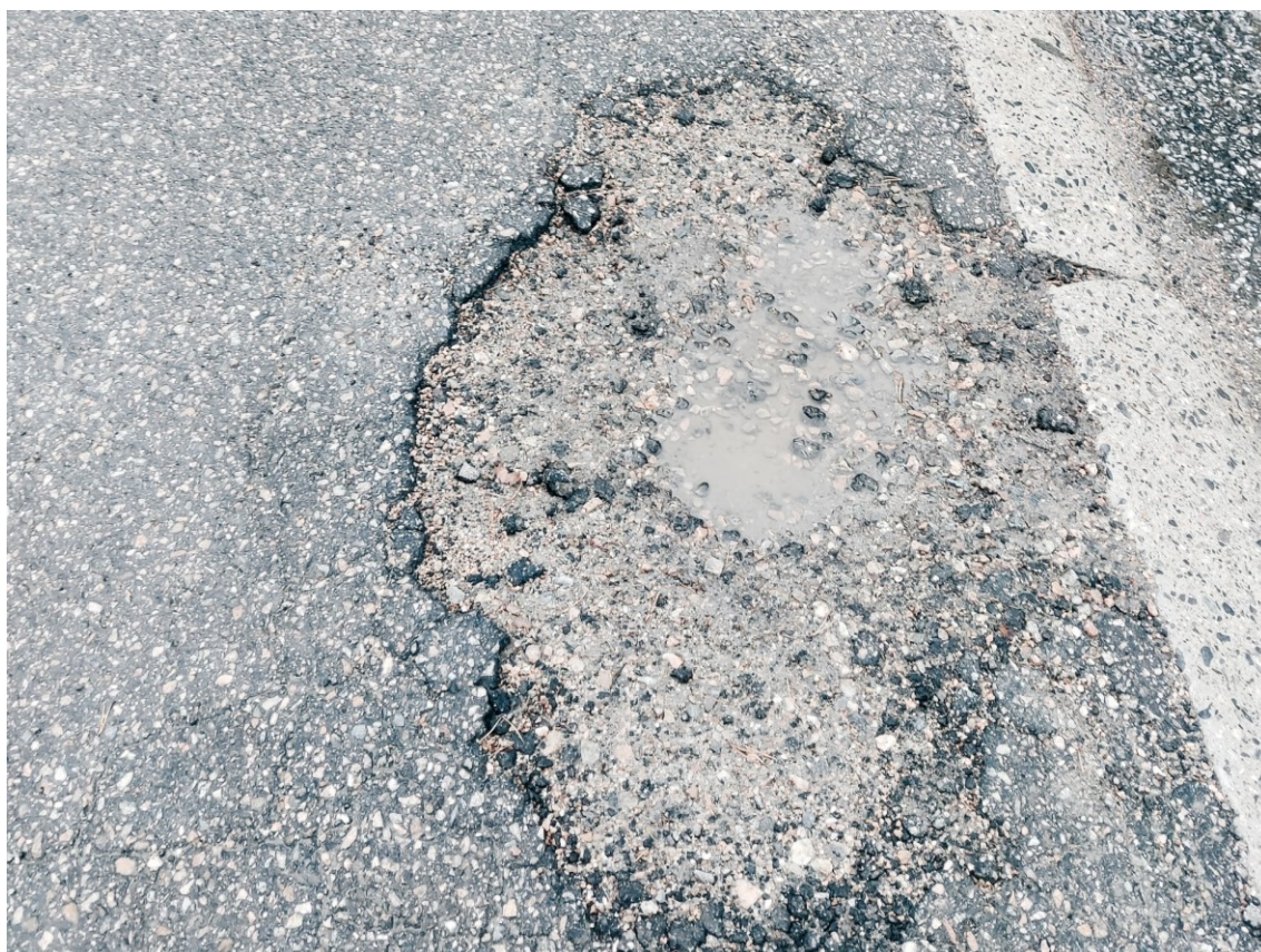
KUVA 3. Tyyppikuva: purkauma (Kalle-Pekka Kolehmainen, 2023).
