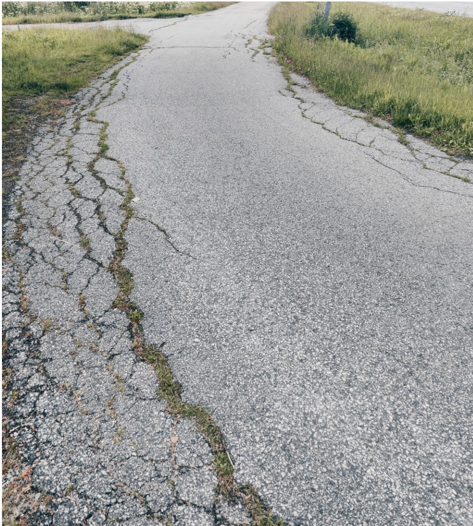
KUVA 15. Verkkohalkeamaa/ reunapainumaa molemmin puolin väylää, Kehrämönttiellä välillä Polvilantie-Kuovikuja.
