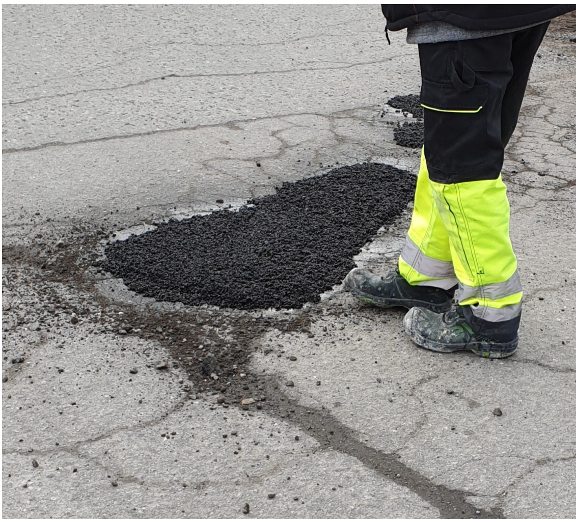
KUVA 10. Asfaltin paikkaaminen paikkausmassalla (RHV, https://www.rhv.fi/asfaltinpaikkaus/ ).
