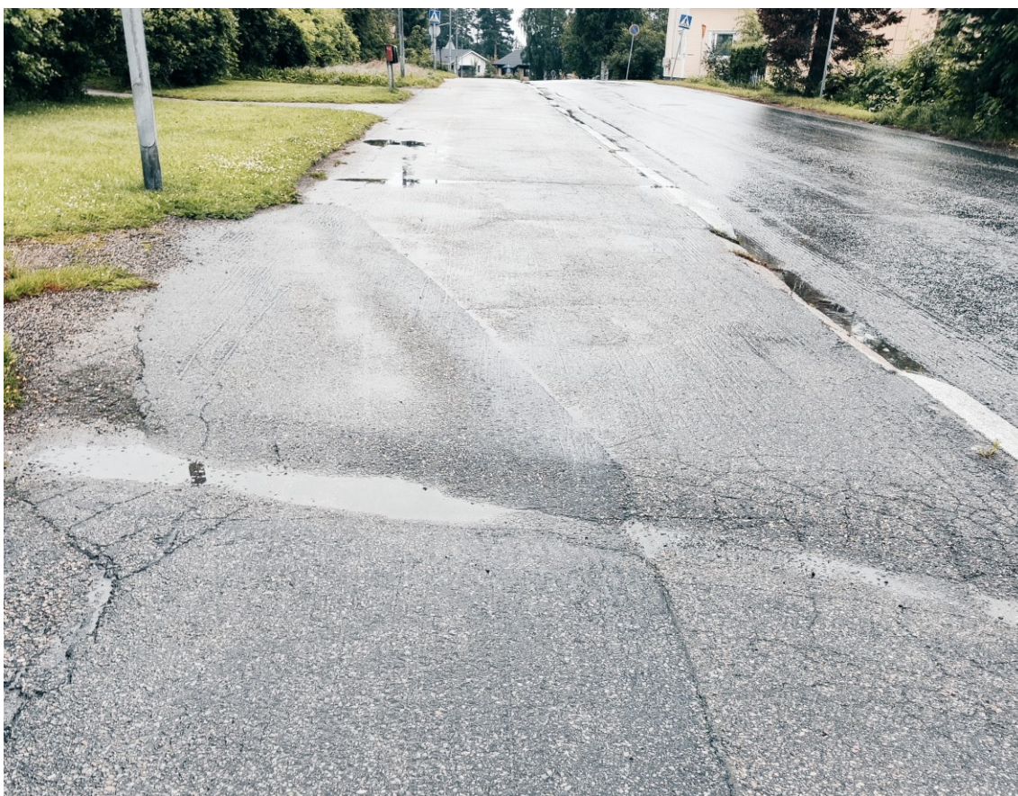
KUVA 4. Tyypikuva: epätasaisuus, pituussuuntainen (Kalle-Pekka Kolehmainen 2023).
