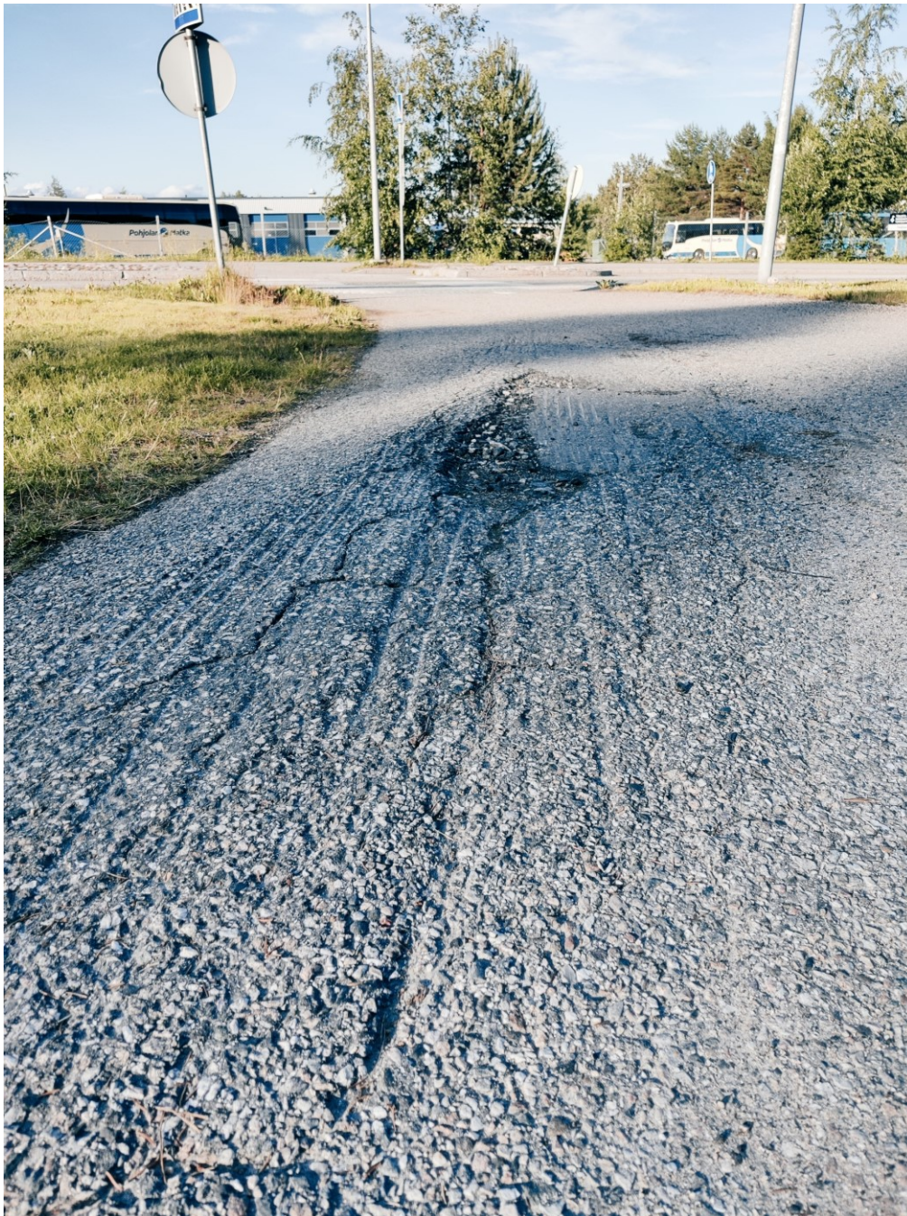
Purkauma ja routanousu, Timperintiellä liikenneympyrässä.
