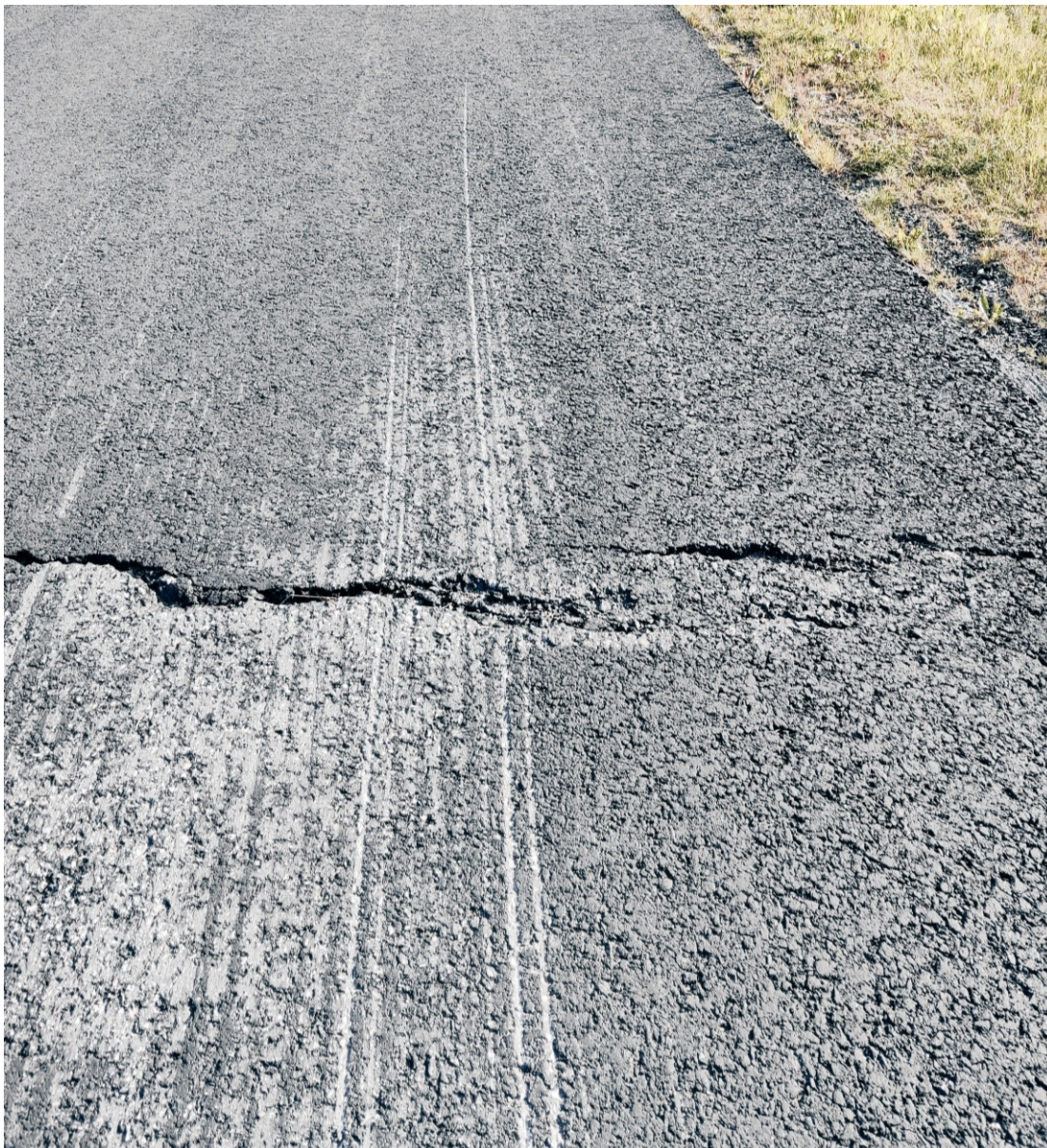
KUVA 6. Tyypik kuva: alusterän raapimisjälkiä pituussuunnassa (Kalle-Pekka Kolehmainen 2023).
