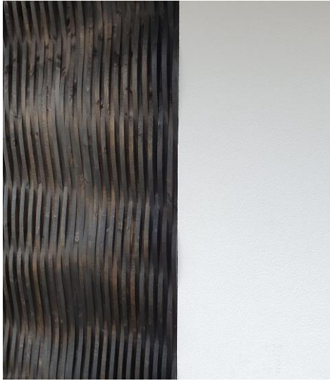
KUVA 34. Villa Havetin vaaleaksi rapattuihin julkisivuihin oli upotettu aaltoilevia puisia yksityiskohtia. (Kuva: Helmi Mäki-Latvala 2023)
