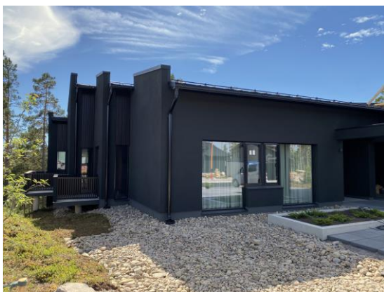
KUVA 30. RS-Insinöörien suunnitteleman ja muuttovalmiiksi toteuttaman Naantalin Aurinkolinnan katujulkisivusta pyrittiin saamaan tiivis ja muurimainen. (Kuva: Jämerä taloideat – Naantalin Aurinkolinna)
