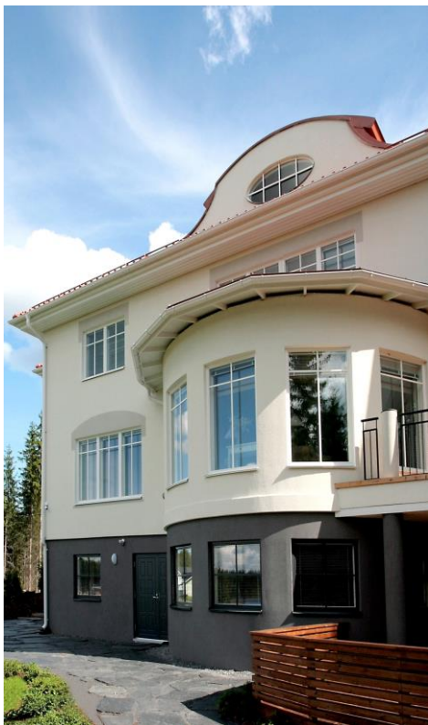
KUVA 17. Vaaleaksi rapatun Lapillin kaareva erkkeri ja kattolyhty luovat rakennuksen ilmeestä kartanomaisen. (Kuva: Jämerä taloideat – Lapilli).
