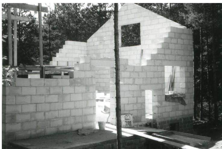
KUVA 4. Kevytbetonirakenteinen omakotitalo rakennusvaiheessa 1950-luvulla. (Kuva: Lauri Leppänen, Viljo Holopainen, Vantaan Kaupunginmuseo 1956)
