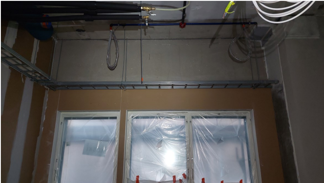
KUVA 9. Hyllyasennuksia tasoittamattomien seinien edessä.
