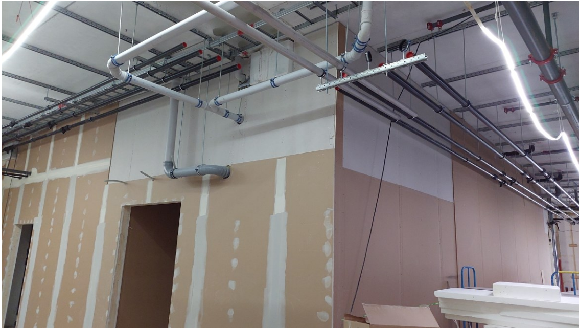
Kuva 4. Yläosassa vajaa levytys ja putkia sekä hyllyjä asennettu tasoittamattoman seinän eteen.
