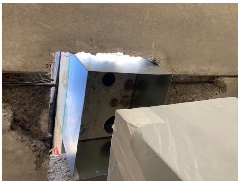
Kuva 11 Asennettu kehys ilman kauluksia
