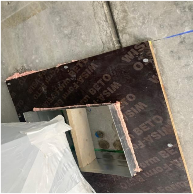
Kuva 12 Asennettu vaneri ja peltikehys valua varten
