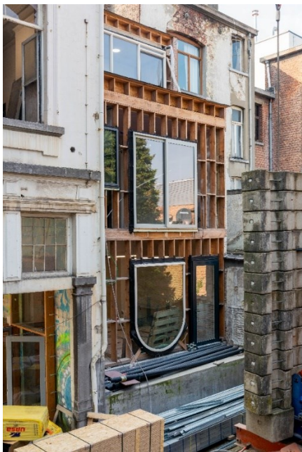
Kuva 1 Masui4Ever second-hand-ikkunat asennettuna julkisivurunkoon. Kuva: Delphine Mathy 2021.
