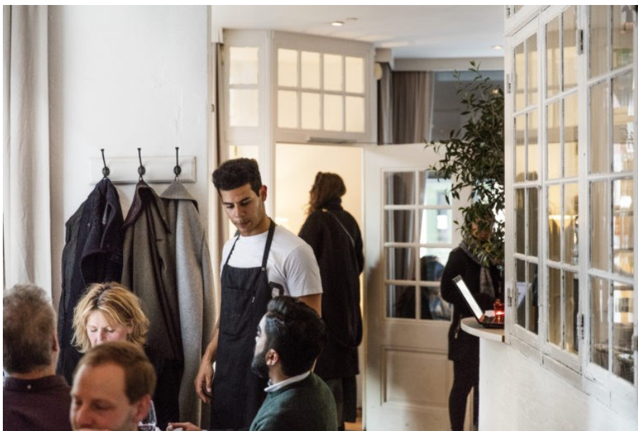
Kuva 20 Ravintolan sisätilojen lasirakenteita vanhoista puikkunoista. Kuva: Genbyg.dk
