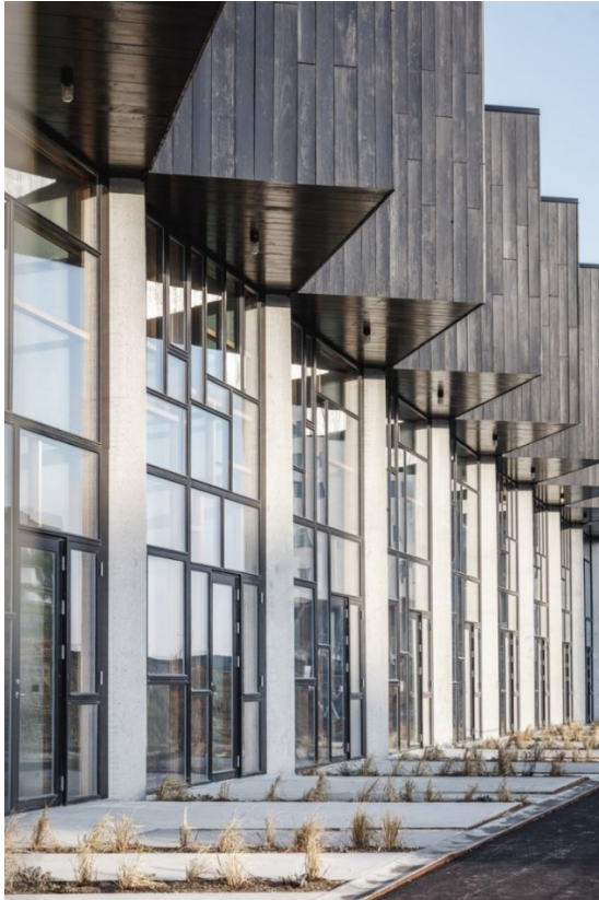
Kuva 8 Upcycle Studiosin julkisivut on koostettu käytetyistä eristyslaselementeistä. Kuva: Lendager Group
