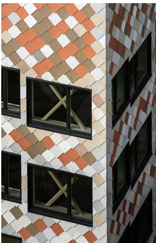
Kuva 5 Erikoiset suojakaiderakenteet estävät putoamisen matalimmalle asettuvista suurista ikkunoista. Samanlainen muoto toistuu muualla rakennuksen sisällä. Kuva: Mad Arkitekter
