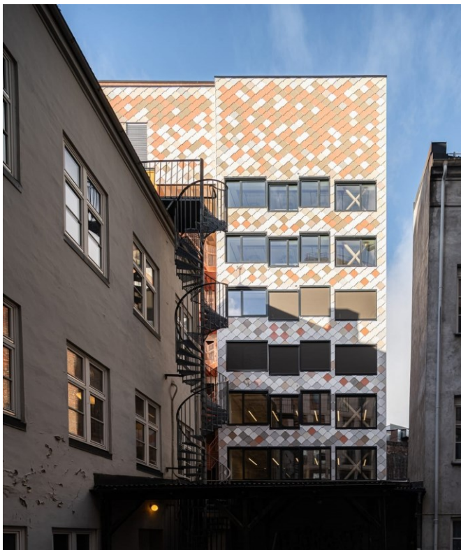
Kuva 4 Uudelleenkäytetyt ikkunat KA13 laajennusosan julkisivussa. Kuva: Mad Arkitekter
