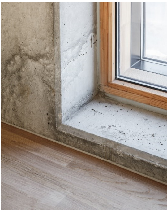
Kuva 10 Lasituksissa on kaksi eristyslaselementtiä rinnakkain ja lasien välissä on ilmarako. Kokonaisuudella on hyvät lämmöneristysominaisuudet. Kuva: Lendager Group
