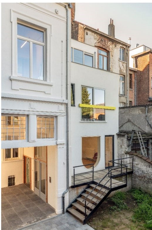
Kuva 2 Masui4Ever second-hand-ikkunat uudessa pinnoitetussa julkisivussa. Kuva: Delphine Mathy 2021
