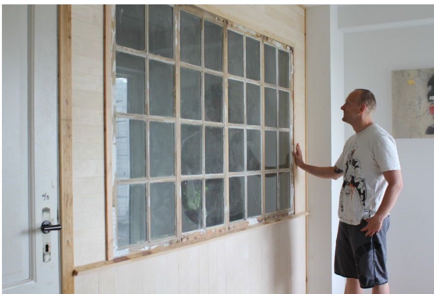
Kuva 18 Genbyg.dk:n toteuttama väliseinä yksityisasunnossa Tanskassa. Kuva: Genbyg.dk
