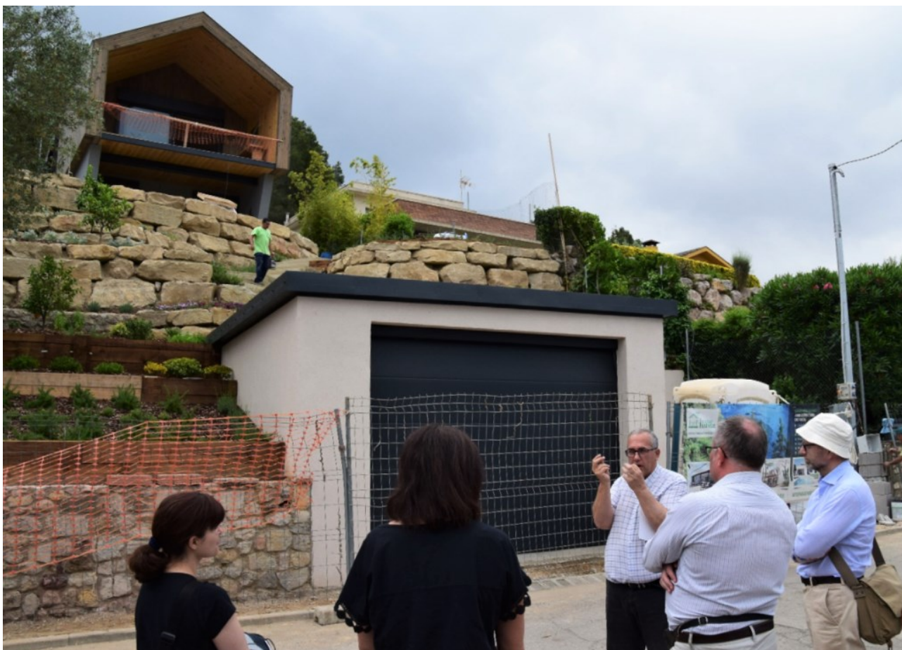
KUVA 3. Kuvassa rakennustyömaalla haastatteluun osallistuneet Laia Haurie (vas.) ja Kàtia Gaspar (UPC), Pere Linares, CEO, House Habitat, Vesa Pitsinki sekä Pekka Harju (Oamk) ja Didac Gordillo (UPC) (kuva: Kai Tolonen).
