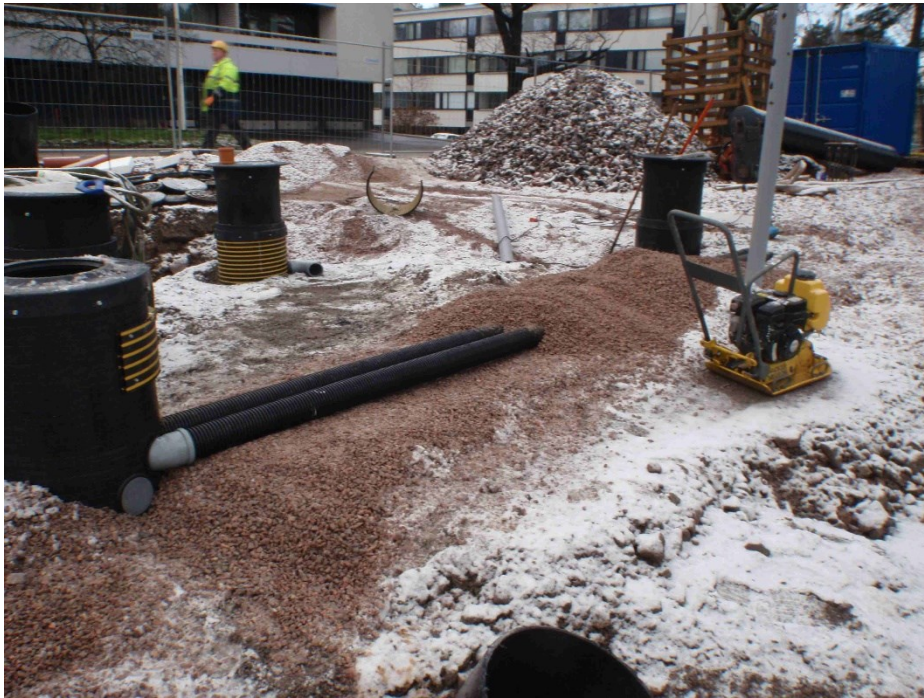
Kuva 20. Salaoja putkien asennus työkohteessa. [8.]
