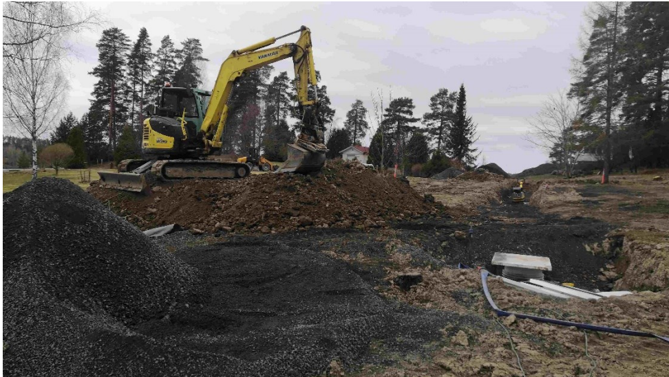
Kuva 22. Ylijäämämaita, kaivannon kuivatusta. [8.]
