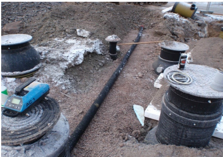
Kuva 18. Salaojan asennusta putkilaserilla. [8.]
