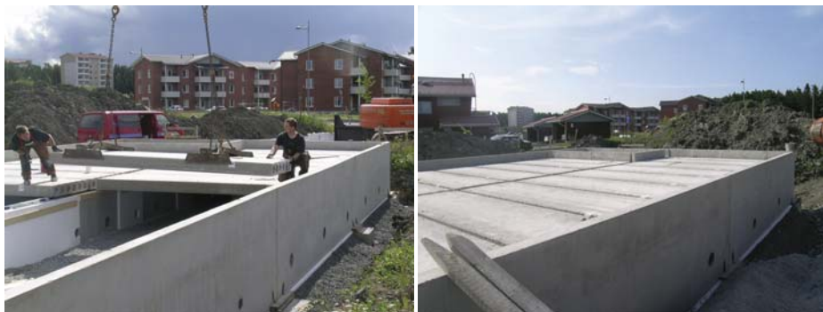
KUVA 6. Ontelolaattojen asennus käynnissä Tasettikujalla. Kuvat: Katja Niskanen.
