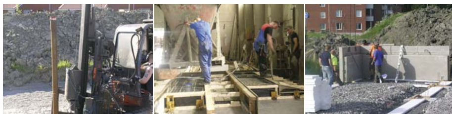
KUVA 5. Tasettikujan paalutustyö, sokkeliementtien betonivalu, sokkeliementtien asennus työmaalla. Kuvat: Katja Niskanen.
