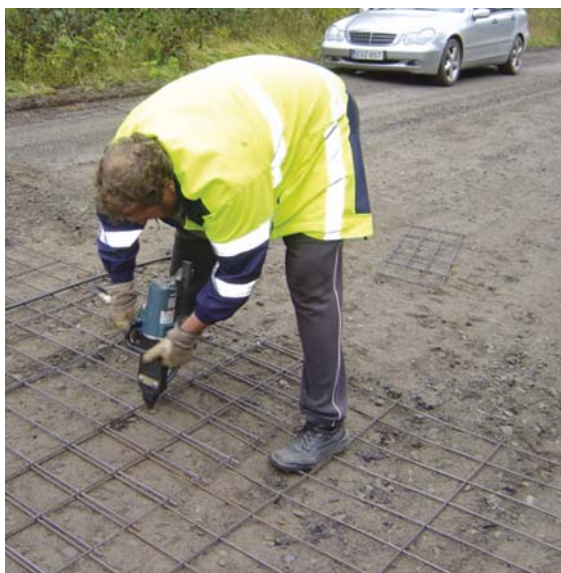
KUVA 5. Teräsverkkojen asentamiseen on patentoitu menetelmä, jota on edelleen kehitetty Turun ammattikorkeakoulun opiskelijoiden toimesta Kuva: Olli Heinilä.
