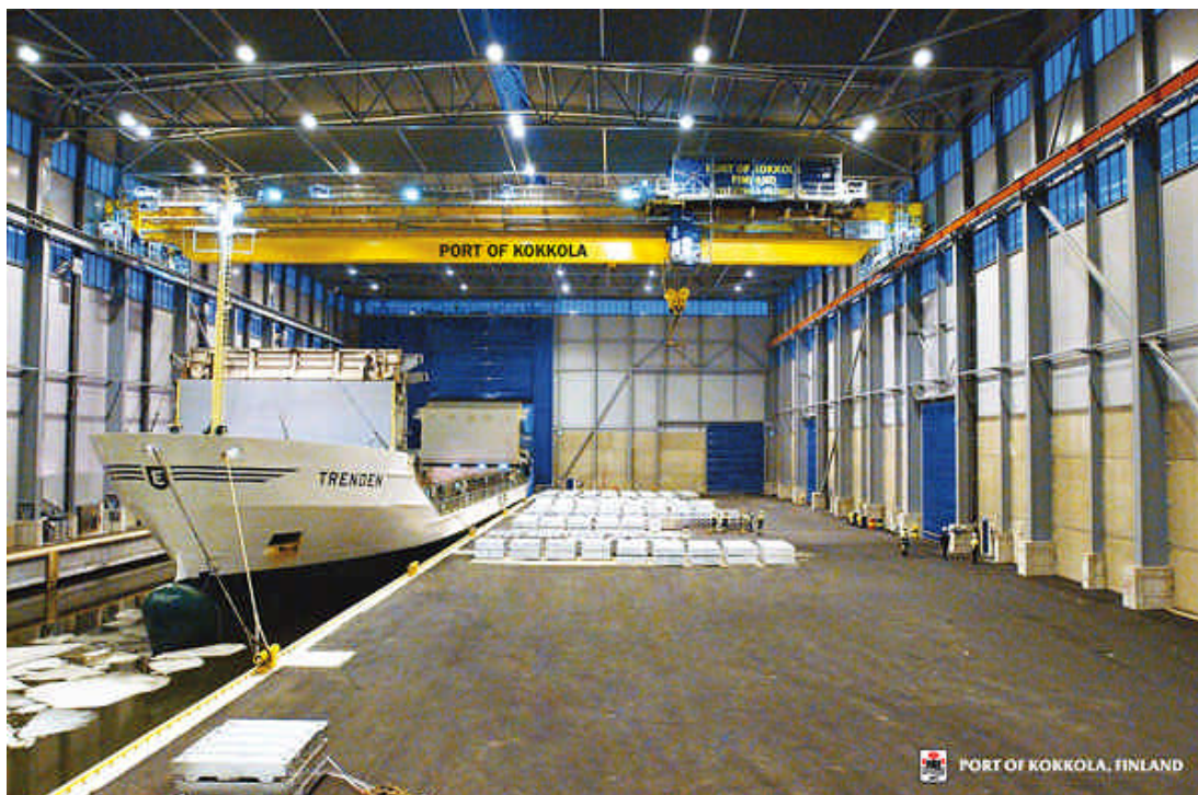
Kuva 6. Italialainen siltanosturi terminaalissa (Kuva: Kokkolan satama)
