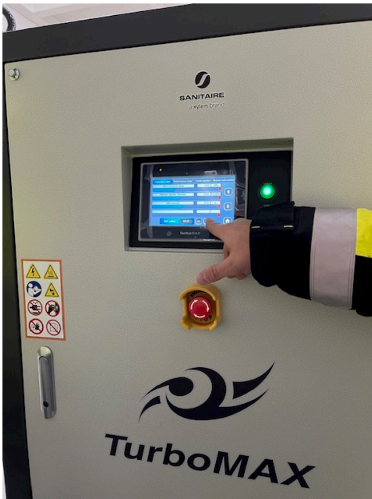
Kuva 22. Ilmastinlaite.
