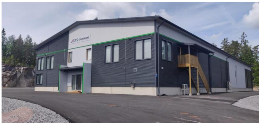
Kuva 2. TAS-Powerin toimitilat Jorvaksessa.
