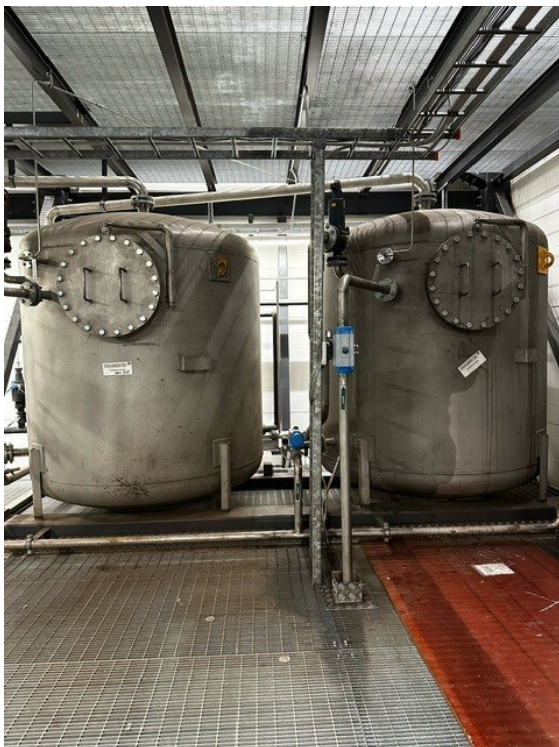
Kuva 24. Hiekkasuodattimet 2KIV4GNB50AT001 ja 2KIV4GNB60AT001.
