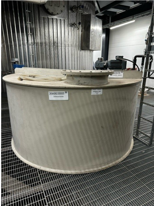
Kuva 18. Selkeytystankki 2KIV4GND30BB001.
