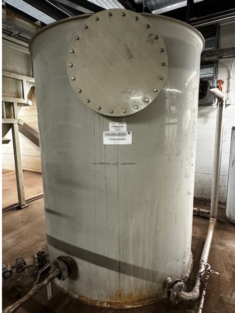
Kuva 23. Pumppaussäiliö 2KIV4GNB40BB001.
