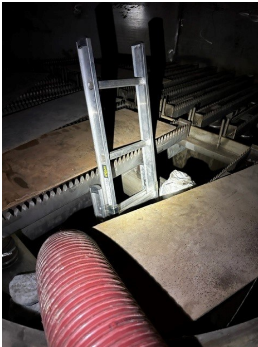
Kuva 16. Täytekappaleiden imurointi kostuttimesta.
