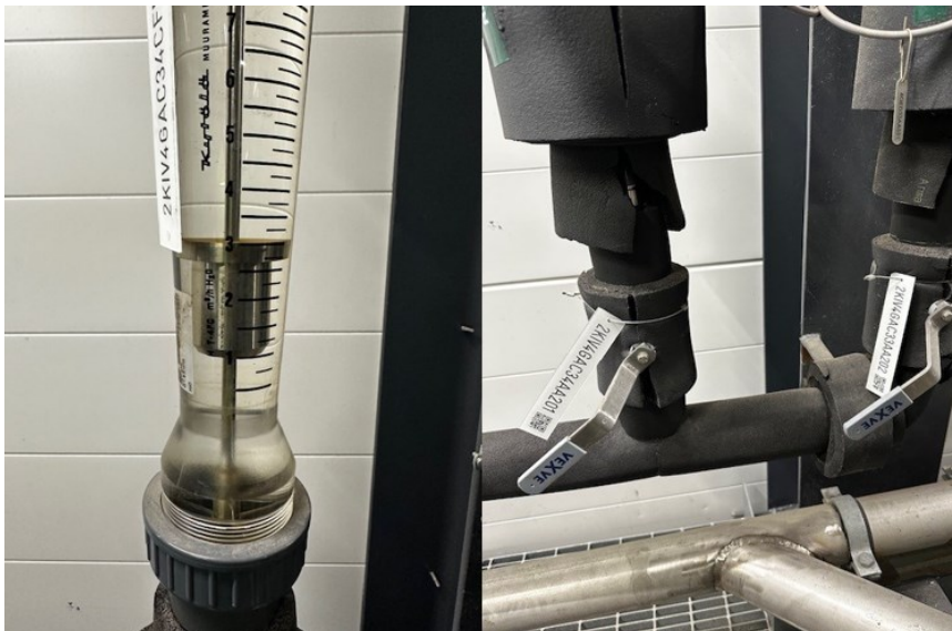
Kuva 38. Venttiilien asento on säädetty noin puoliväliin.
