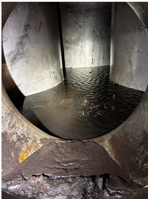
Kuva 8. Pesurin vesitilan pohjalla tuhkapitoista vettä, joka täytyy imuroida pois tyhjennyksen yhteydessä.
