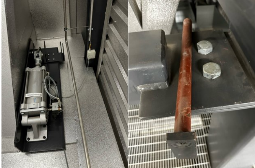
Kuva 43. Pelti lukitaan laittamalla rautakanki sylinterin päällä olevista rei'istä.
