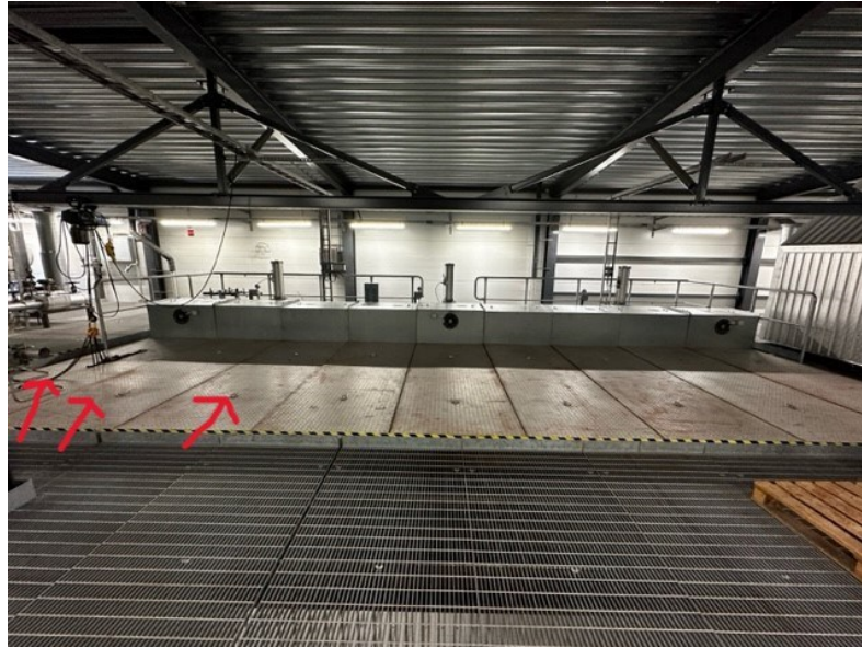
Kuva 47. 1-kammion kansiluukut.
