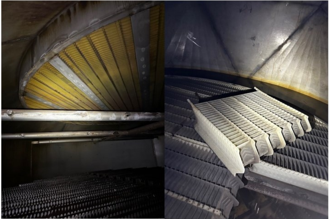
Kuva 13. Pisaranerottimet makaavat kannattimien päällä. Levyt tulee asentaa osoittamaan nuolet ylöspäin.
