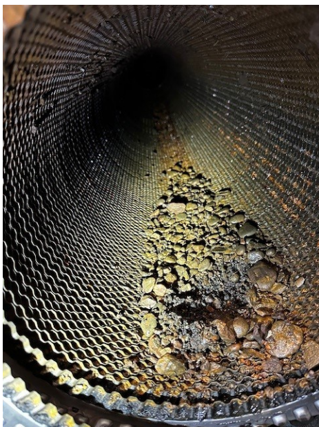
Kuva 49. Kiviä oli päätyntä tavallista enemmän lämmönvaihtimeen, sillä KL-pumpuilla ei ollut imusihtejä.
