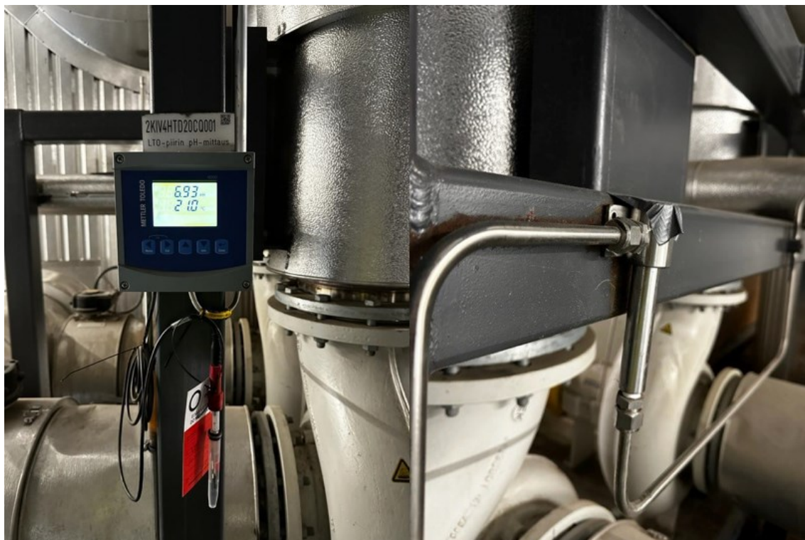
Kuva 9. pH-mittauksen analysaattorien elektrodit laitetaan suojaliuokseen säilönän ajaksi. Suojataan antureiden kupit teipeillä.
