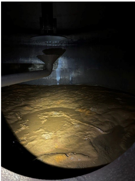
Kuva 25. Hiekan tarkastus revisiossa 2023. Hiekka oli puhdasta, joten hiekkaa ei vaihdettu.
