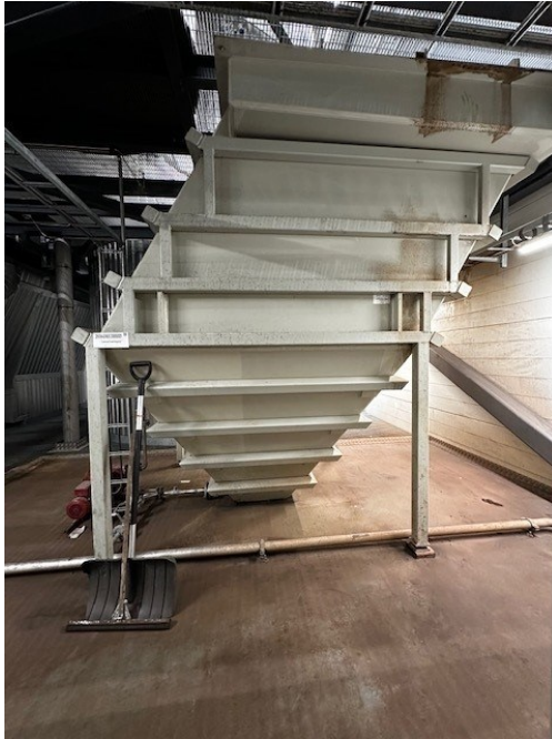
Kuva 19. Lamelliselkeytin 2KIV4GNB20BB001.
