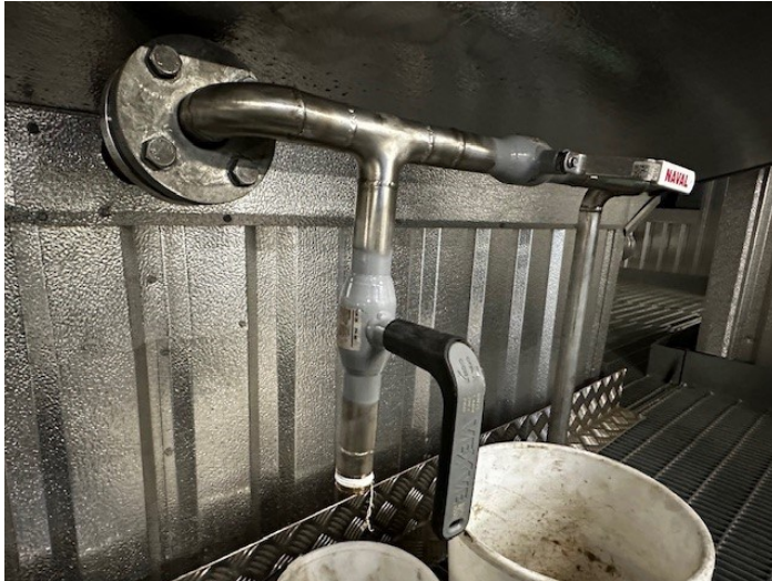
Kuva 36. Tyhjennysventtiili hitsattiin 22.1.2024 märkätuhkalinjaan juuri ennen kattilaa.
