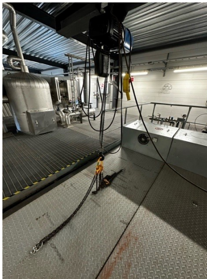
Kuva 46. Kannot nostetaan kuvassa näkyvän nostimen avulla sivuun.
