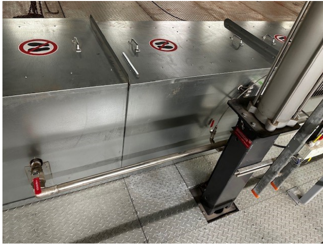
Kuva 45. Suljetaan punainen puhdistusilmaventtiili oikeasta kammiosta.
