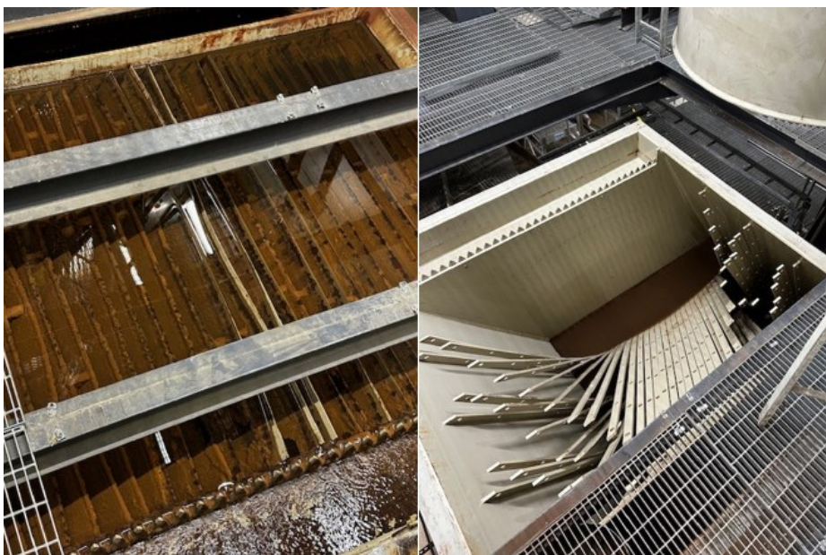
Kuva 22. Lamelliselkeytin vasemmalla puolella levyjen kanssa ja oikealla puolella ilman levyjä.
