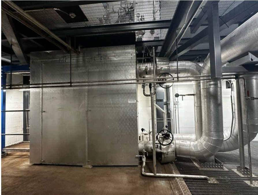
Kuva 28. LTO-lämmönvaihdin 2KIV4HTD31AC001.
