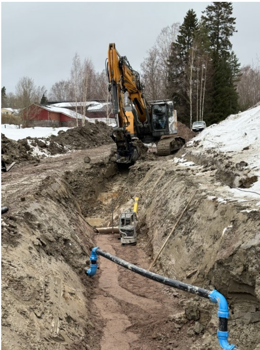
Kuva 11. Kaivinkone suorittamassa vesihuoltokanaalin aukikaivuuta [Roope 2024].
