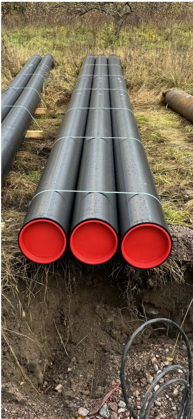
Kuva 9. 315 PE -putket varastoituna työmaalla [Roope 2023].
