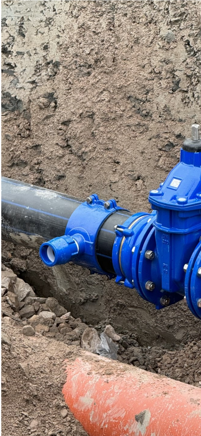
Kuva 4. Tonttiliitoksen toteutus kierresatulalla [Roope 2023].
