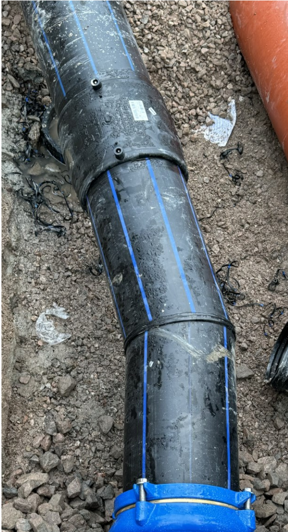
Kuva 3. Sähköhitsausmuhvi sekä 15°:n vesijohtokulma [Roope 2023].
