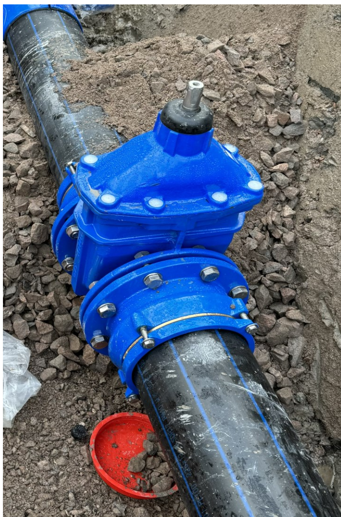
Kuva 2. DN 200 laippaventtiili ja vetokestävät laippaliittimet [Roope 2023].
