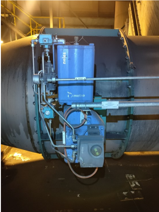
KUVA 4. Jäähdytysilmapuhaltimen kuristussäätö.
