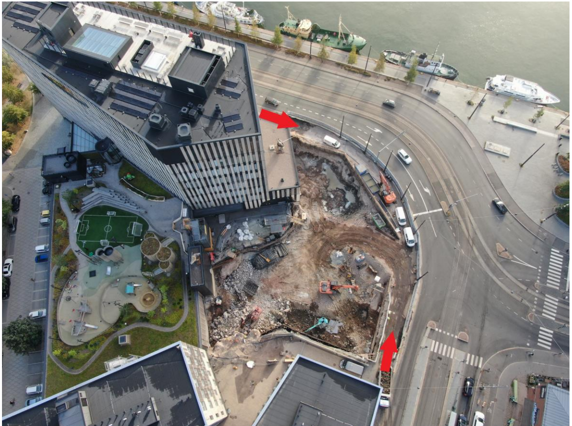
Kuva 9. Ilmakuva Wood City toimisto 2 -työmaasta maanrakennusvaiheessa. Kuvaa muokattu. Kuva otettu 16.8.2022 [19.]
