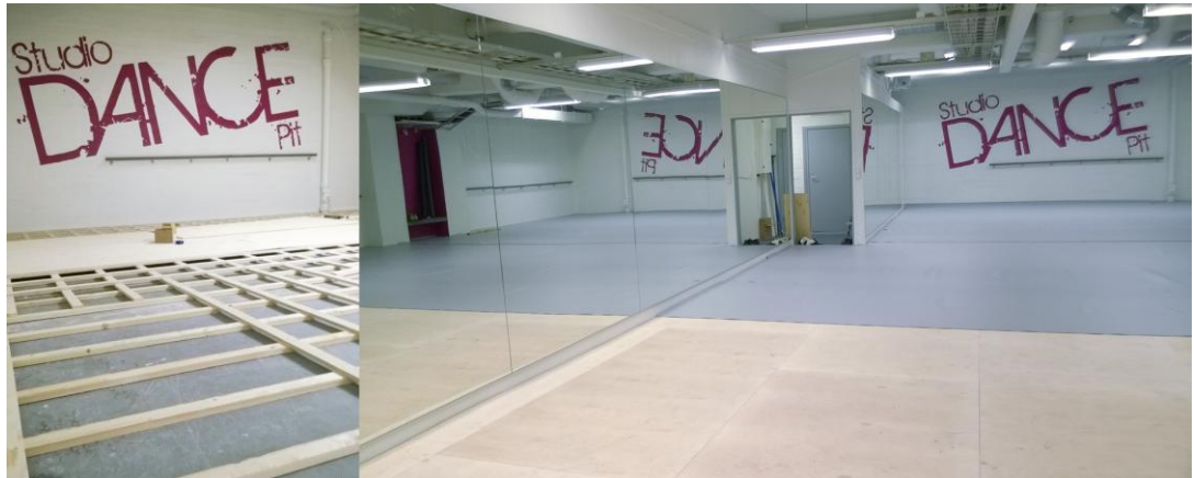
Kuva 22. Joustolattian rakennusvaiheita (Törmikoski, 2014)
