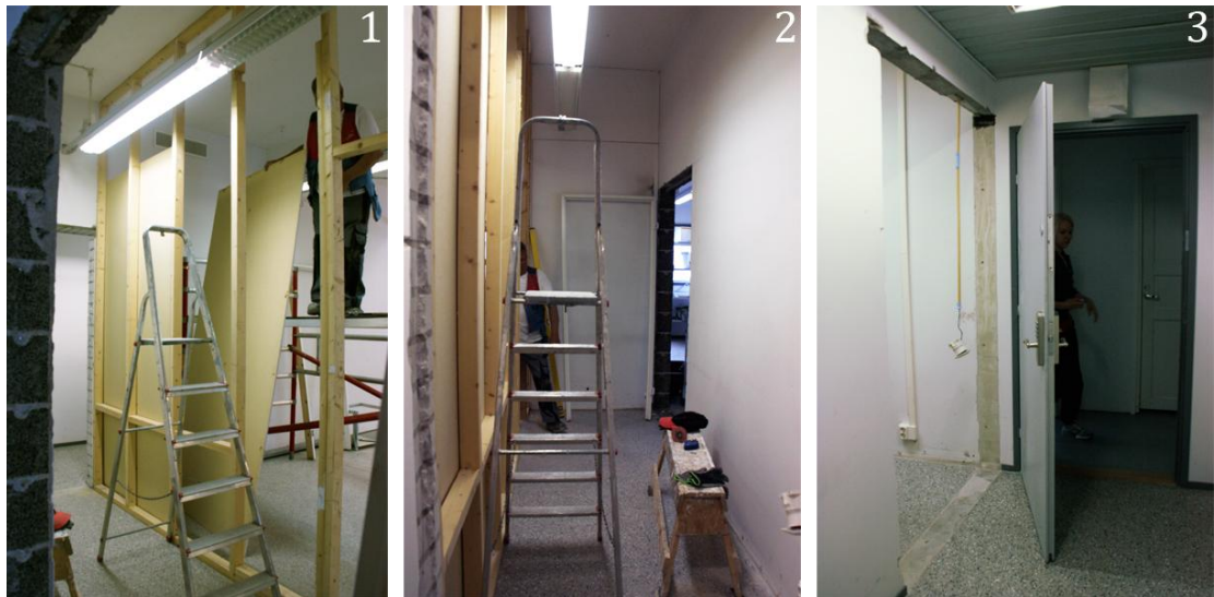
Kuva 19. Vanhojen seinien purku ja uusien rakentaminen (Törmikoski, 2014)
