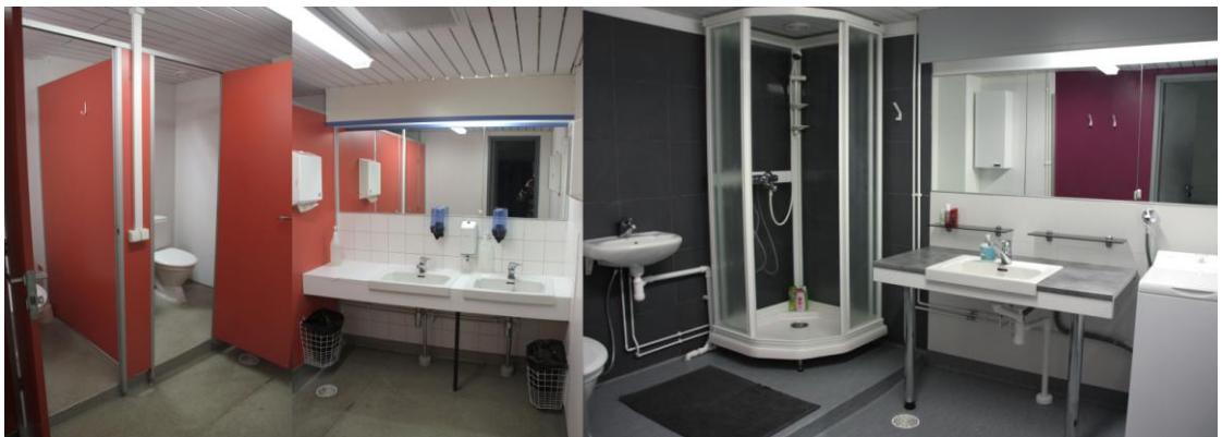
Kuva 24. Suihkutila ennen ja jälkeen remontin
