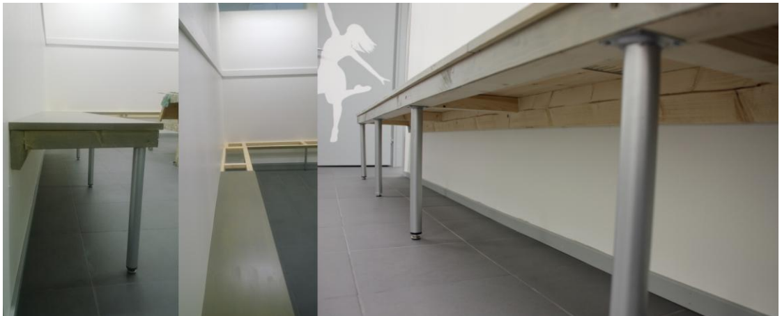
Kuva 38. Pukuhuoneiden penkkien rakennusvaiheita (Törmikoski, 2014)
