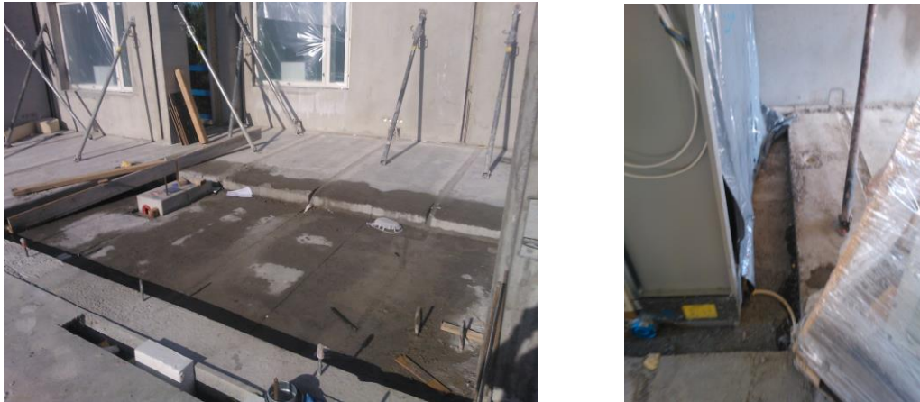
Kuva 21. Kylpyhuone-elementtien alle jäävä asennustila.
