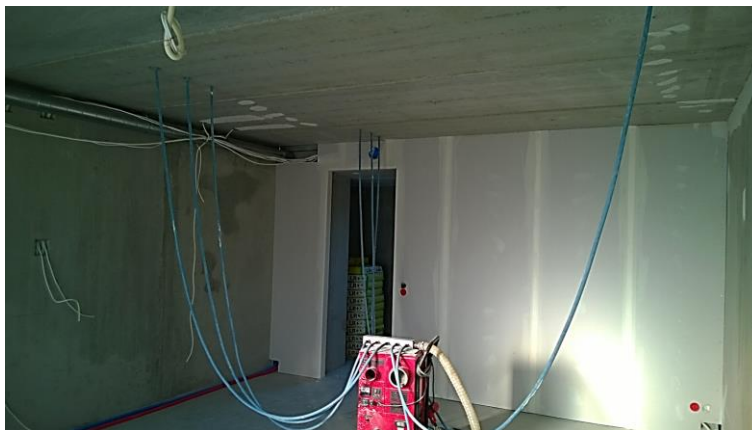
Kuva 20. Onteloiden koneellinen kuivaus.
