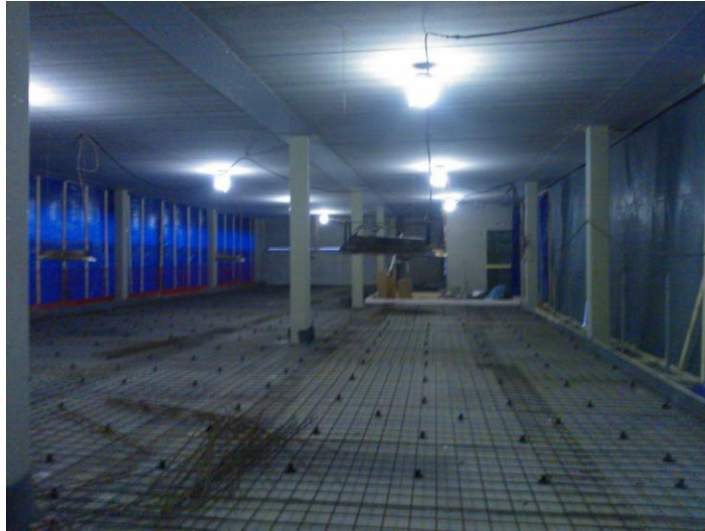
Kuva 4. 11 kW säteilijä ripustettuna katosta.
