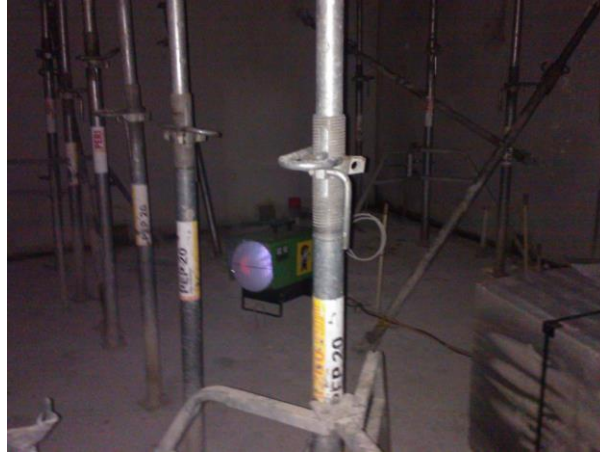
Kuva 8. 30 kW:n kaasukäyttöinen lämpöpuhallin.
