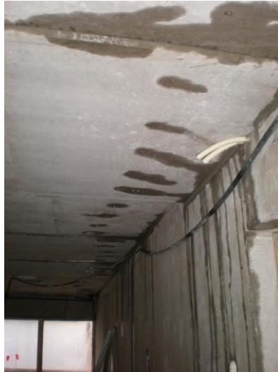
Kuva 18. Kastuneet ontelolaatat.
