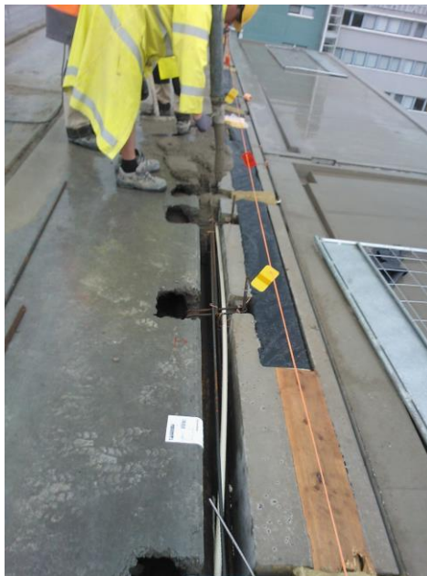
Kuva 19. Elementtien saumavalu.
