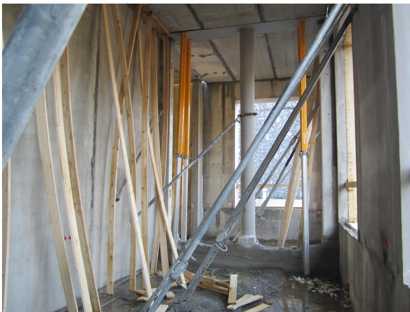
Kuva 10. Ontelolaatan reunakaistamuotin ja elementtien tuenta As Oy Espoon Reimarissa [7].
