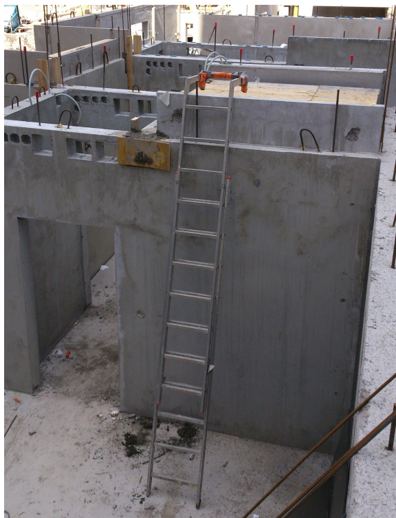
Kuva 11. Työskentelyä tikkailla tulee välttää, mutta elementtiasennuksessa se ei ole useinkaan mahdollista [9].
