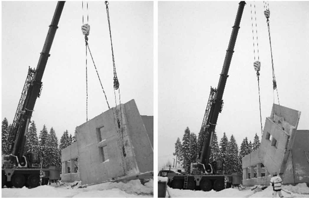
Kuva 6. Elementin kääntäminen ajoneuvonosturilla, jossa on kaksi vaijeria [9, s. 6].
