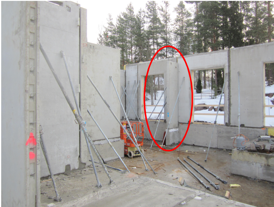
Kuva 9. Kuvassa on ympyröitynä kapea väliseinäelementti, joka on kiinnitetty toiseen elementtiin hitsaamalla. Lisäksi kuvassa näkyy vinotukien käyttöä. Kuva on otettu maaliskuussa 2013 As Oy Espoon Ulapasta [7].
