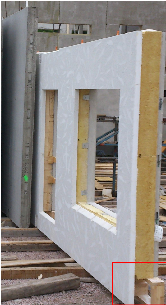
Kuva 7. Elementit ovat varastoituina karnatelineeseen aluspuiden päälle. Kuvassa näkyvän ulkoseinäelementin sisä- ja ulkokuori ovat eri tasoissa, joten sisäkuori on tuettava varastoidessa erillisellä muotilla [6].
