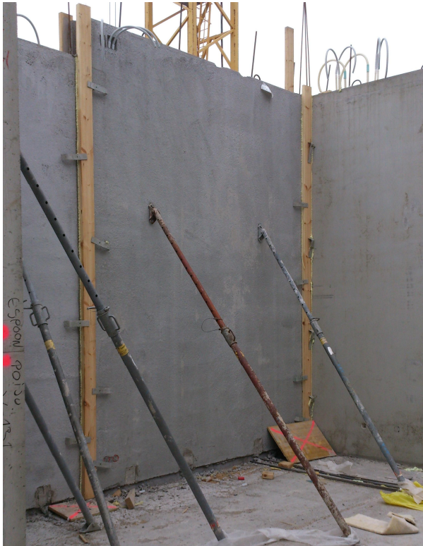
Kuva 4. Pystysaumot muotitettuina. Korkeissa saumoissa valupaine kasvaa, joten muottien kiinnitys on tehtävä huolellisesti [6].
