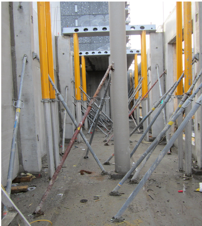
Kuva 5. Elementtien tuentaa ensimmäisen kerroksen liiketilassa. Kuva As Oy Espoon Reimarista marraskuulta 2012 [8].
