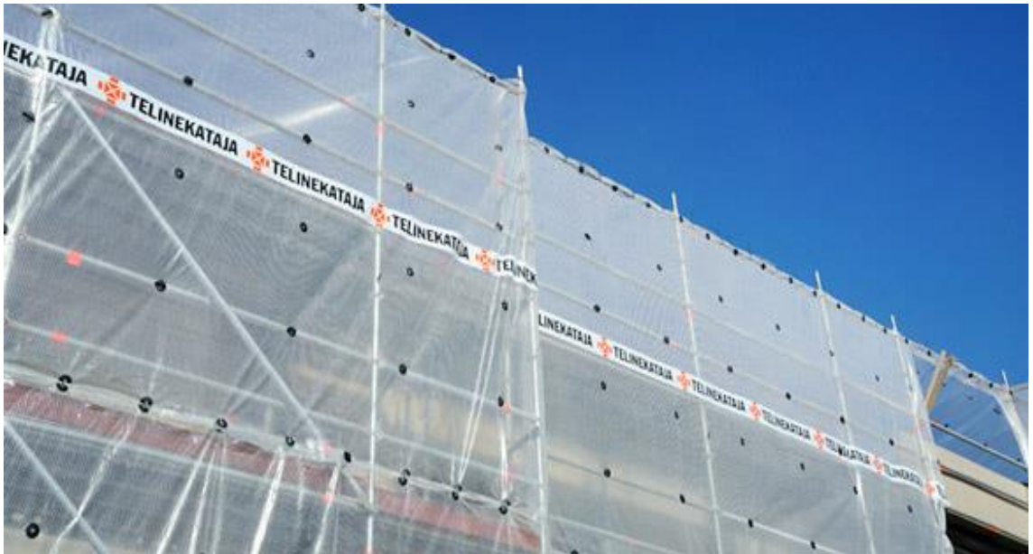
Kuva 11. Telinepeite on kiinnitetty telineisiin tiukasti ja pitävästi. [16.]
