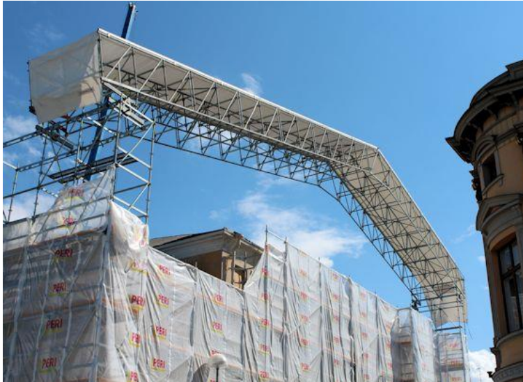
Kuva 12. Sääsuojan noston suorittaminen osissa.[17]
