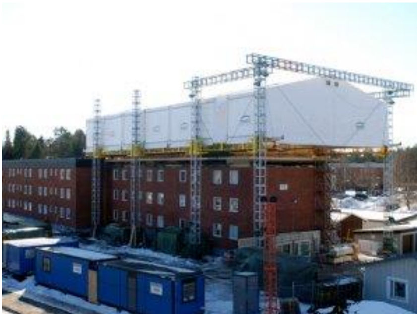
Kuva 3. Gibson Tower -sääsuoja on rakennettu niin suureksi, että tavaran toimitukset voidaan purkaa sääsuojan alla. [9.]
