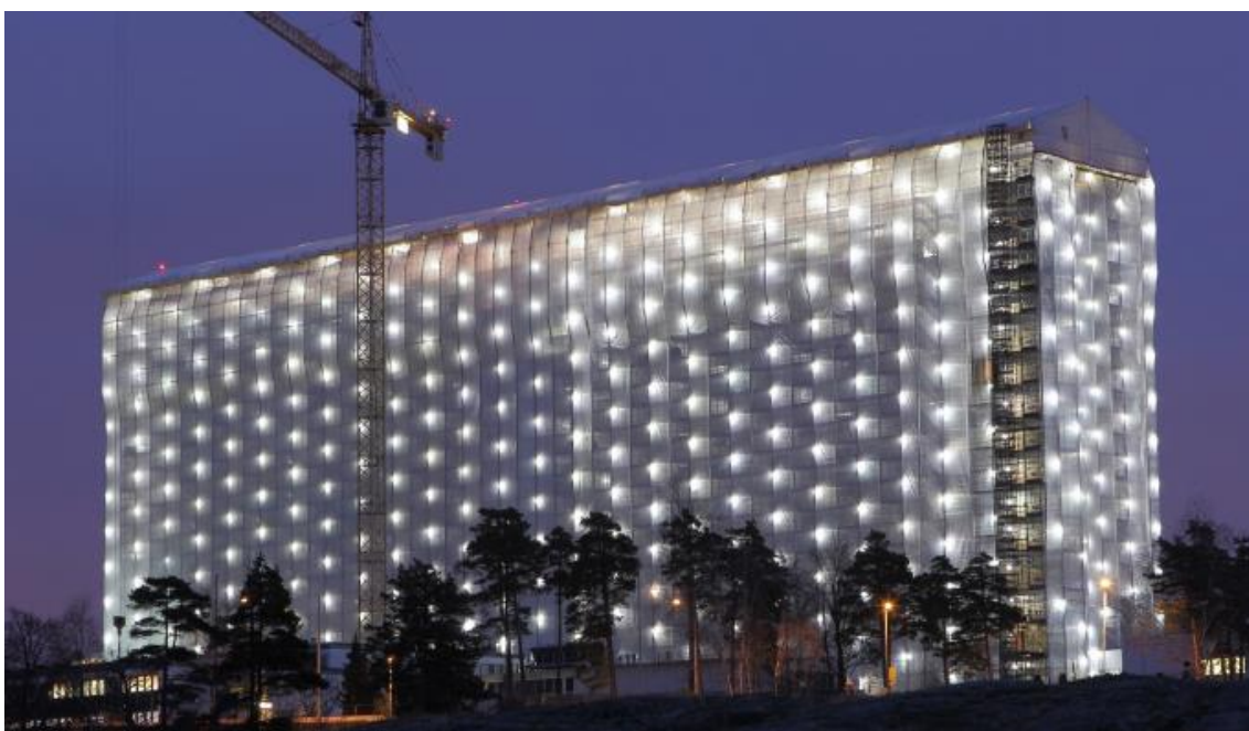
Kuva 13. Kokorakennuksen suojaava perinteinen sääsuojaus eli "huputus". [18.]
