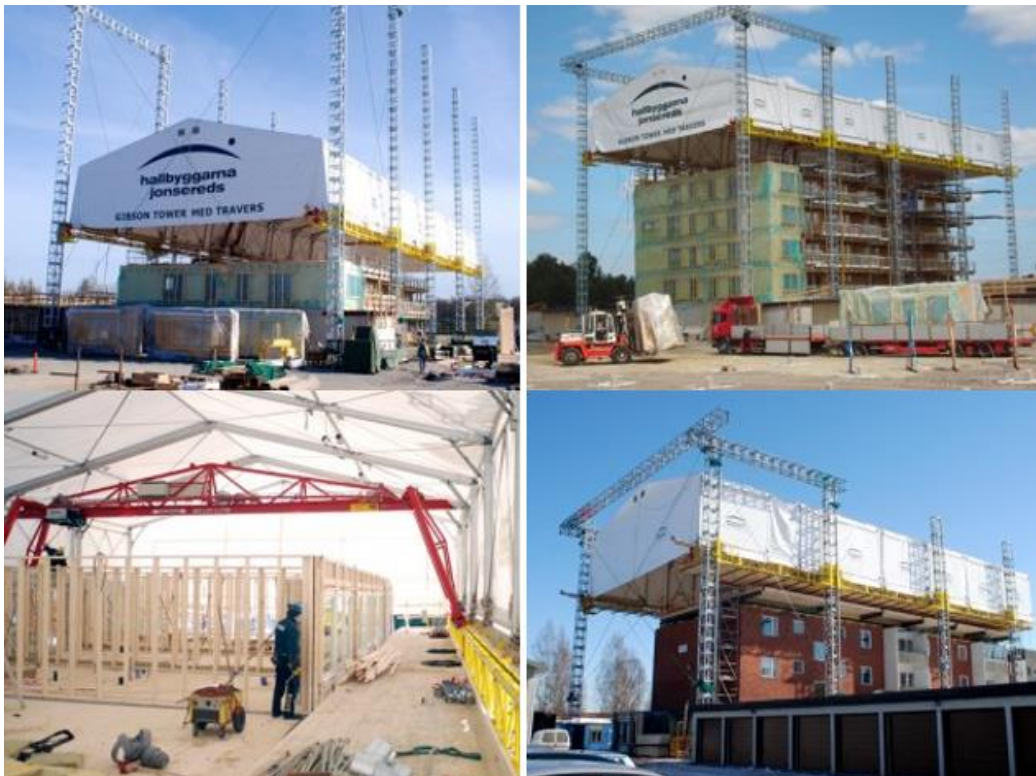
Kuva 4. Gibson Tower -sääsuoja, jota voidaan nostaa ylöspäin rakennuksen rungon noustessa. Puukerrostalotyömaalla siltanosturia voidaan käyttää sääsuojan alla nostotöihin. [9.]
