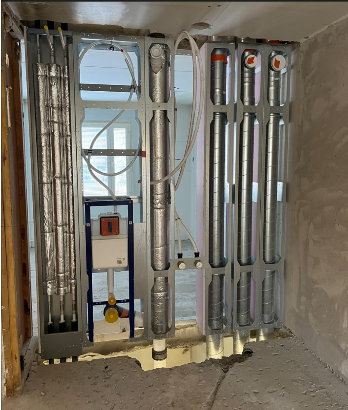
Kuva 4. Uponor talotekniikkahormielementti.
