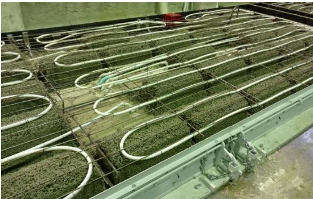
Kuva 2. Luja-Superlaatta tehtaalla ennen pintavalua [6].
