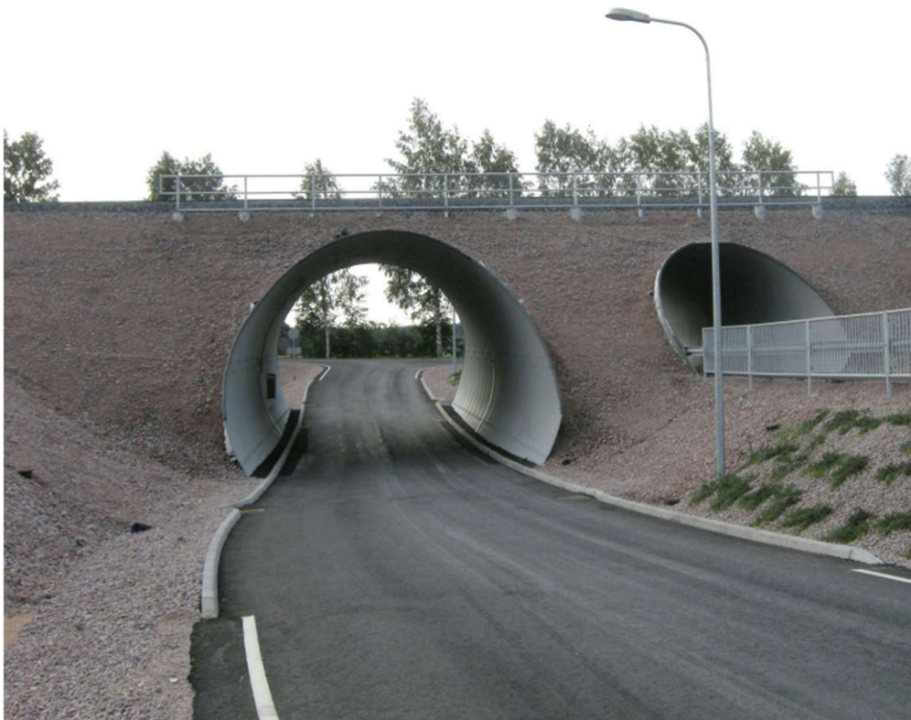
KUVA 1. Teräspuutkisilta. (Liikenneviraston ohjeita 2014)
