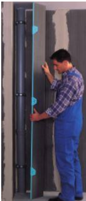
Kuva 29. Wedi-kotelon asennus [27 s. 7]
