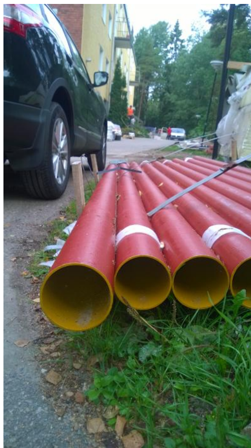
Kuva 42. Työmaalle varastoidut epoksinpinnaiset valurautaviemäriputket.
