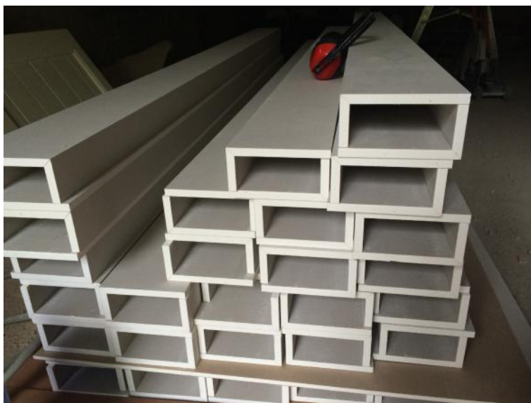
Kuva 39. Kotelot kuljetettiin työmaalle vastakkain ladottuna.
