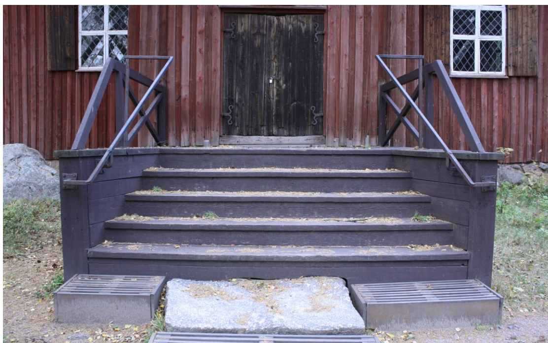
Kuva 16. Karunan kirkon pääsisäänkäynnin portaisiin on lisätty rautakaiteet kulkua helpottamaan (Malmi 2014)
