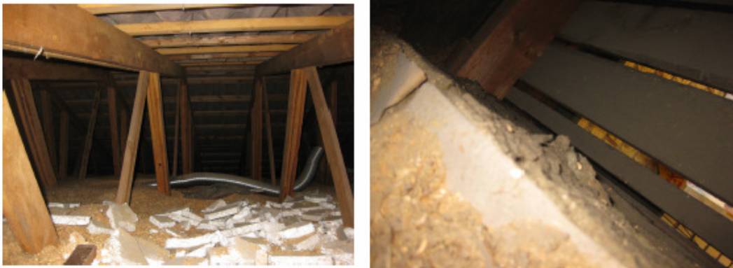
KUVA 1. Näkymä tarkistusluukusta ja räystään tuuletusrakoj
