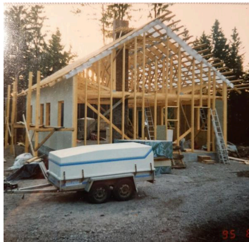
35. Rakennusaikainen valokuva, yläpohjarakennetta
