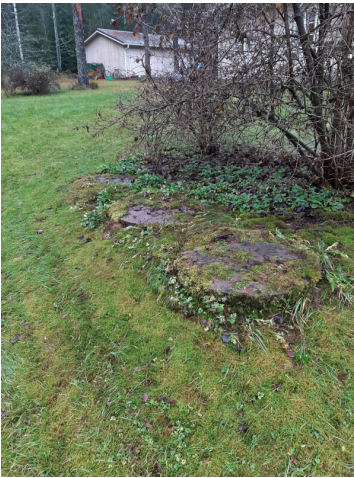
74. Saostuskaivot, eivät tarkastushetkellä avattavissa
