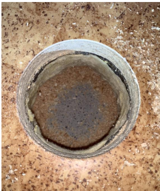
KUVA 24. Lattiarakenneavausta, jossa ei havaittu olevan vauriota.
