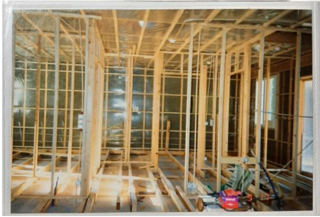
6. Rakennusaikainen valokuva, sisärakenteita
