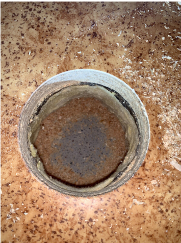
9. Lattiarakenteessa ei kosteuden viittaavaa jälkeä
