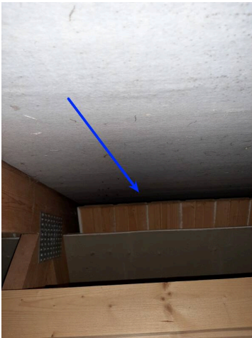
38. Yläpohjan tuuletus räystäältä
