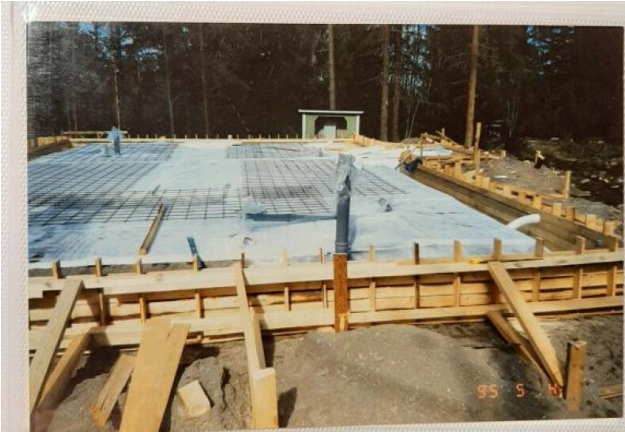
5. Rakennusaikainen valokuva, alapohjarakennetta
