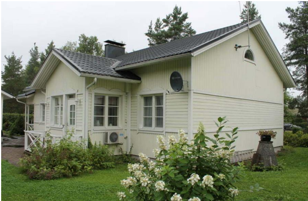
KUVA 7. Tyypillinen 1990-luvun puuelementtirakenteinen omakotitalo (Suomela 2023).
