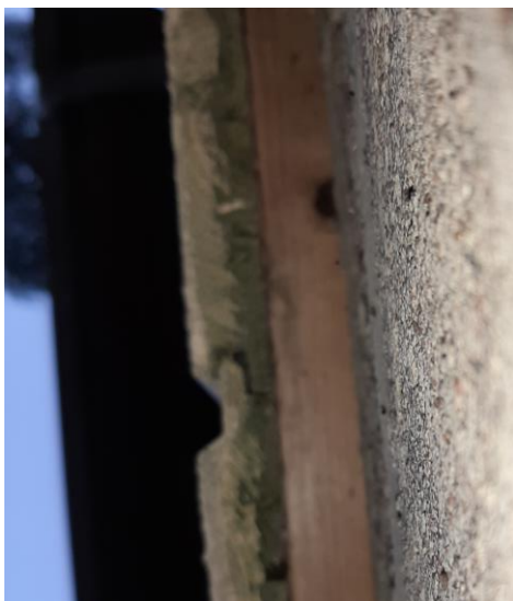
KUVA 25. Pystypuuverhouksen taustan vaakakoolaus, eikä ylä- ja alareunasta ulkoilmaan yhteydessä olevaa tuuletusväliä ole havaittavissa verhouksen takana.
