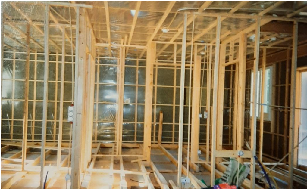
KUVA 21. Rakennusaikainen valokuva sisärakenteista, jossa muun muassa havaittavissa betonilaatan yläpuolista puulattiarakennetta ja höyrynsulkumuovia asennettuna ulkoseiniin ja yläpohjaan.
