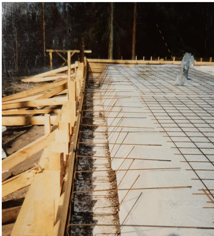
KUVA 20. Rakennusaikainen valokuva perustus- ja alapohjarakenteesta.
