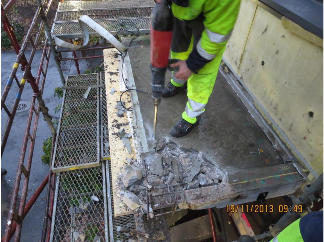
Kuva 13. Mallipurku 1. kerroksen parvekkeella
