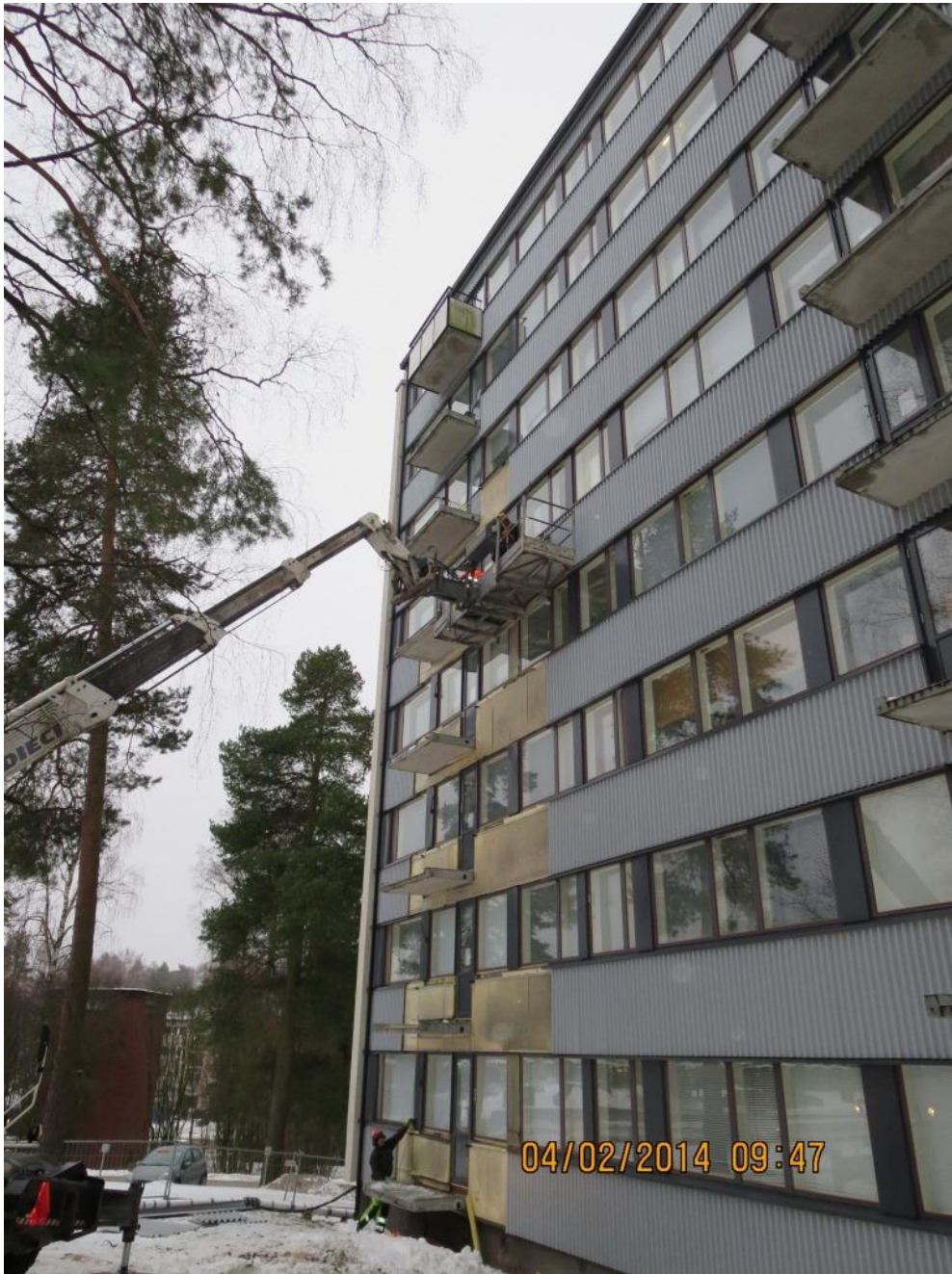
Kuva 15. Julkisivupellityksen poistoa
