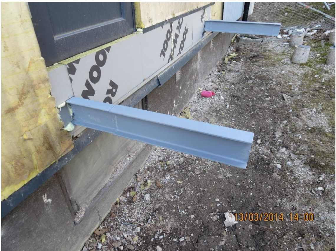
Kuva 20. Parveke-puukko jatkettuna ja ruostesuojattuna
