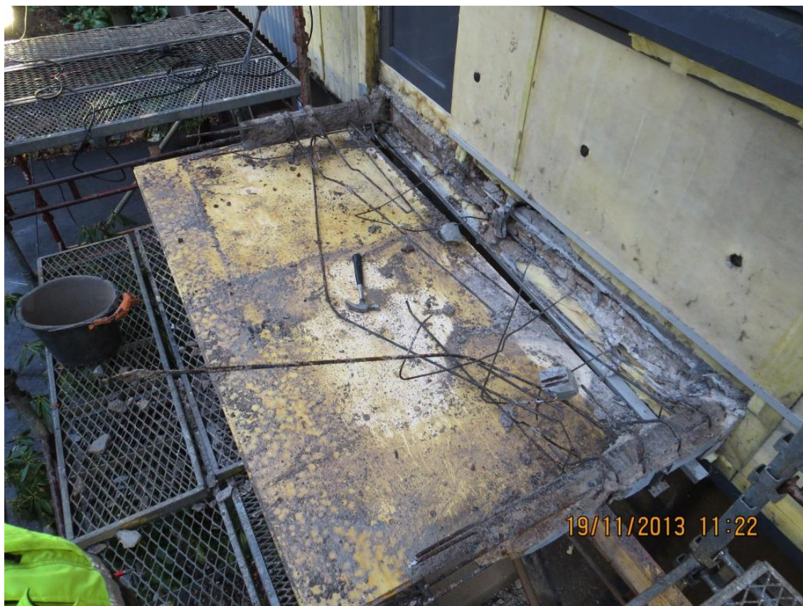
Kuva 14. Parveke-laatta betonin poiston jälkeen
