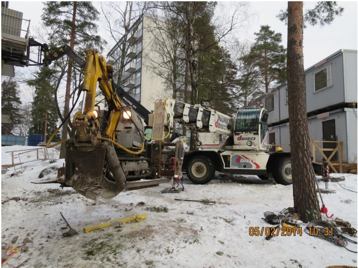
Kuva 17. Brokk -purkurobotti kurottajan piikeillä
