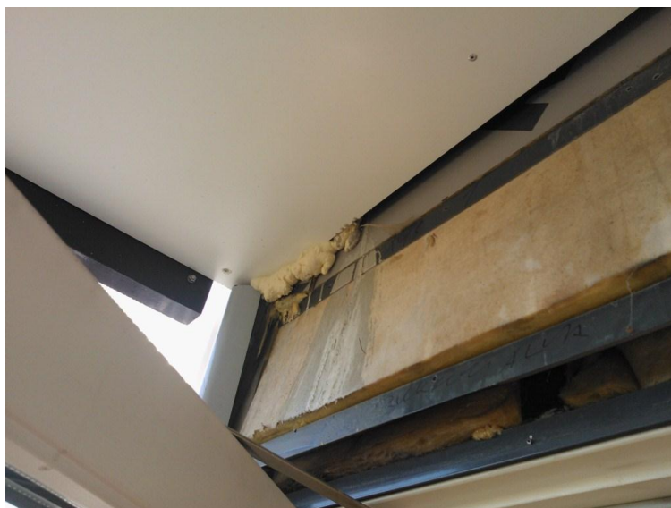
Kuva 27. Juotosbetonivaluma
