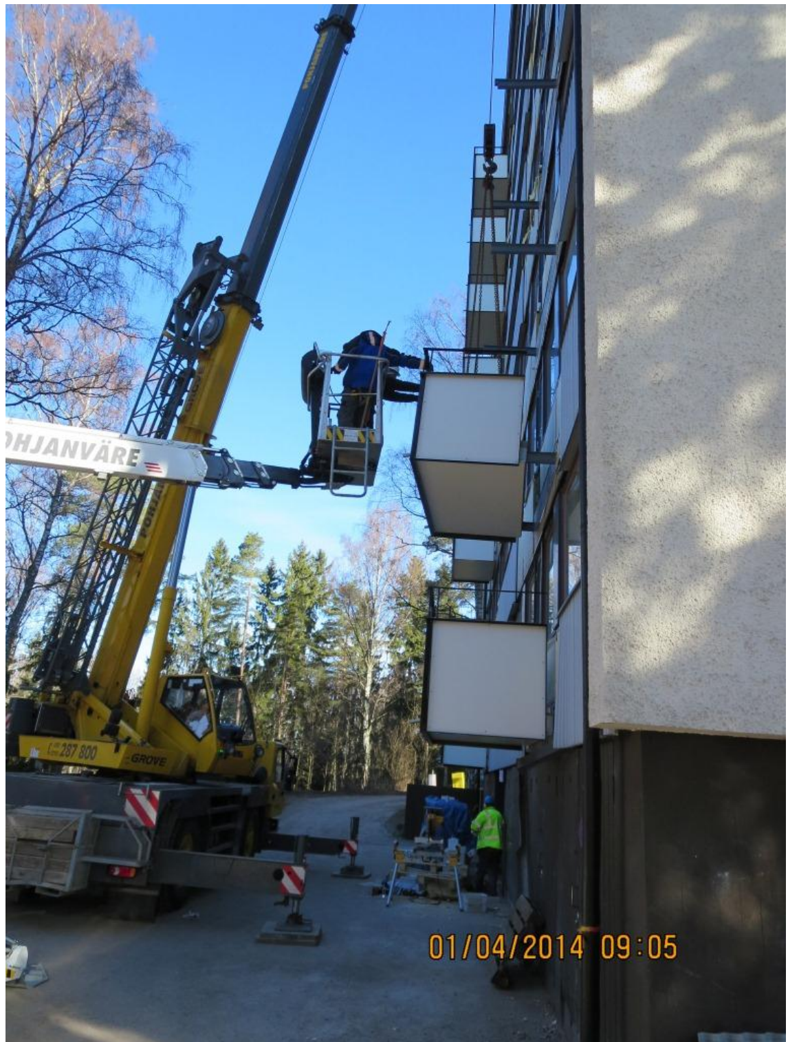
Kuva 22. Parvekkeen asennus käynnissä
