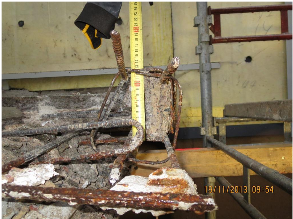
Kuva 10. Rullamittausta parvekepuukosta
