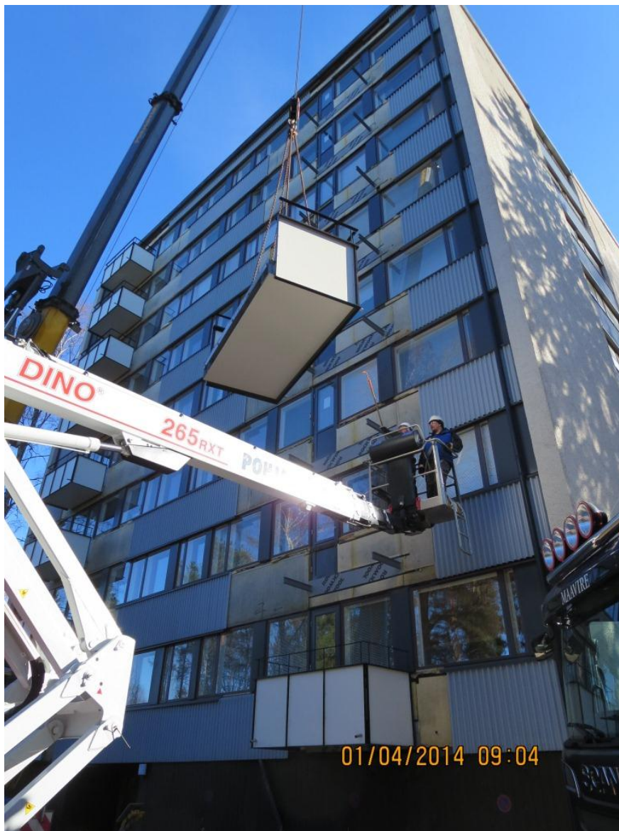
Kuva 21. Parvekkeen asennus käynnissä
