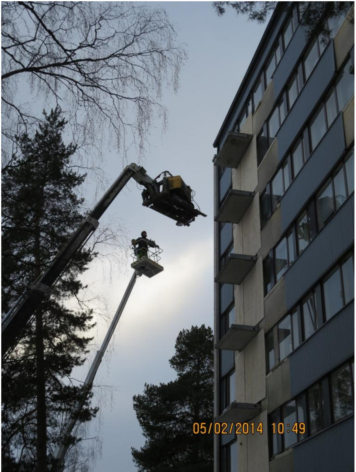
Kuva 18. Parveke-laattojen purku alkamassa
