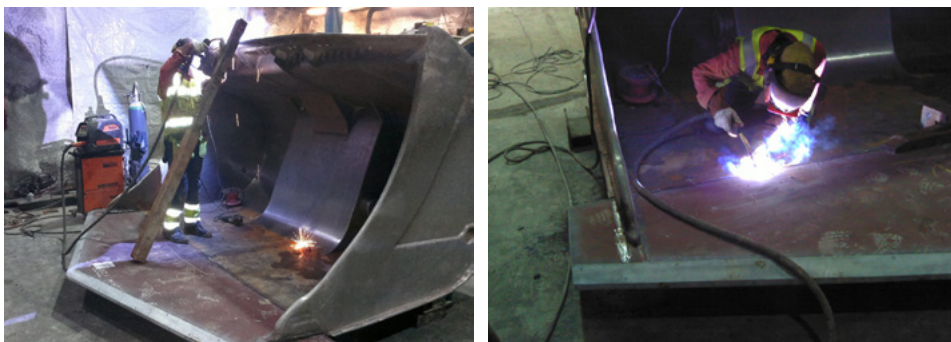
Kuva 13. Uuden huulilevyn silloitus ennen varsinaista hitsausta.
