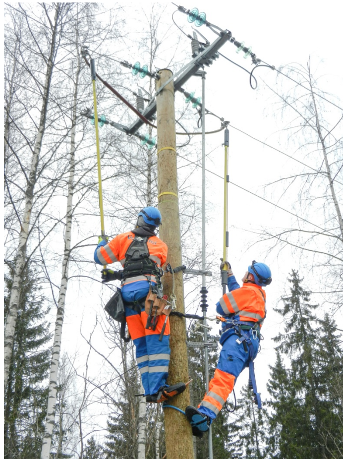
KUVA 1. Jännitteisen 20 kV johtoerottimen huolto. Kuva HeadPower Oy / Rantakallio Marko
