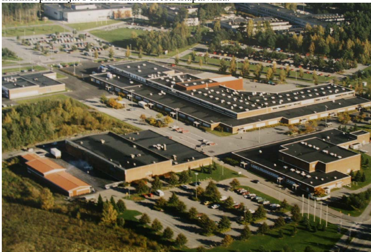
Porin Ammattiopiston tekniikan päärakennukset
