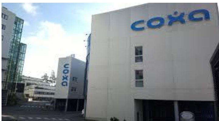
KUVA 5. Coxan rakennus Biokadulla, joka sijaitsee potilashotellin vieressä noin kymmenen metrin etäisyydellä (Tekonivelsairaala Coxa 2014b.)
