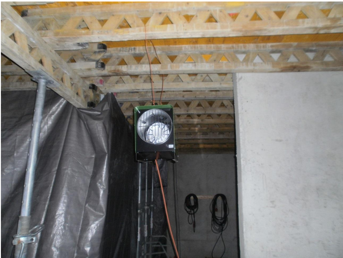
KUVA 7. Betonin lämmitystä kaasukäyttöisellä kuumailmapuhaltimella
