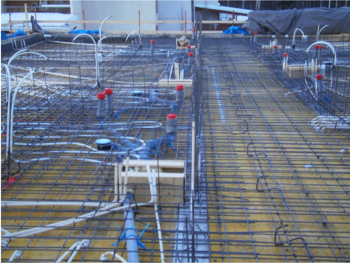
KUVA 5. Välipohjan raudoitukset ja talotekniset asennukset valmiina
