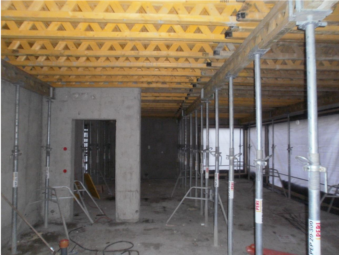
KUVA 4. Peri Multiflex –holvimuottijärjestelmä asennettuna
