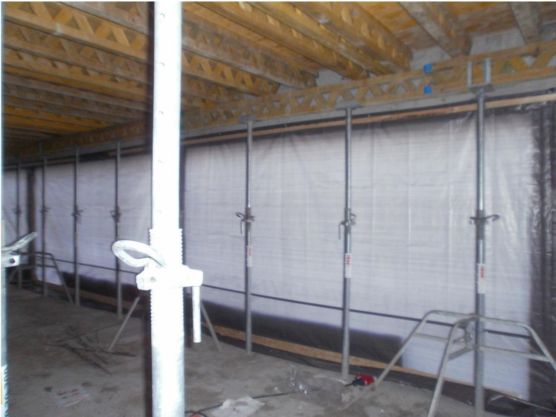
KUVA 8. Vasta valetun holvin alapuolinen tila lämpösuojattu kuumailmalämmitystä varten
