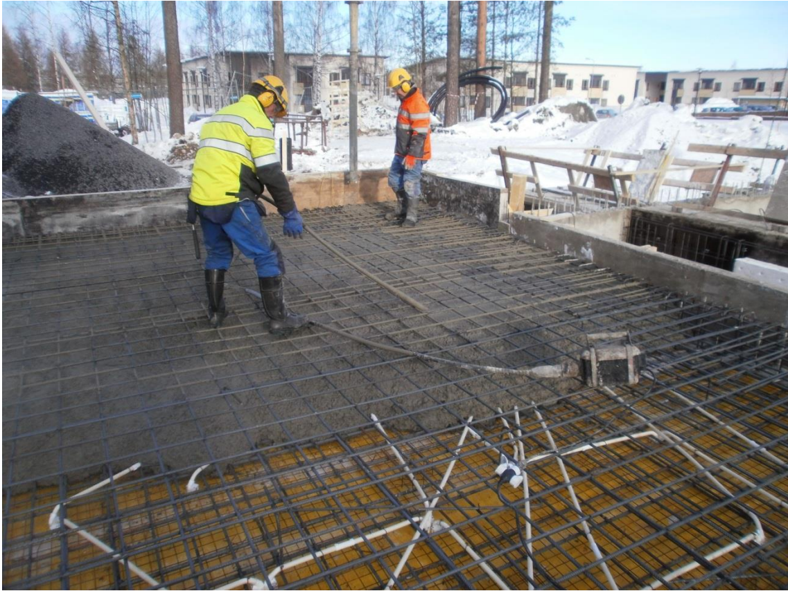
KUVA 6. Betonin tiivistystä sauvatäryttimellä
