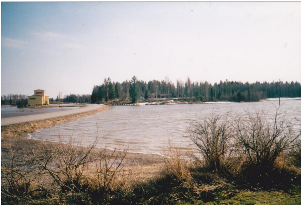
Kuvio 5. Båskaksen vanha pumppamorakennus ja uuden laitoksen rakennuspaikka sijaitsevat Kyrönjoen tulva-alueella. /11/
