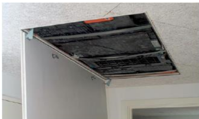
Kuva 12. Yksikön pohja (suodattimen vaihto) (9, s.7)
