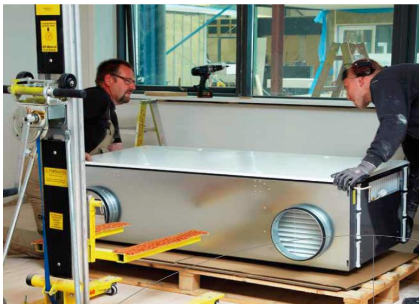
Kuva 8. Vaihe 1. Yksikkö tuodaan kohteeseen.
