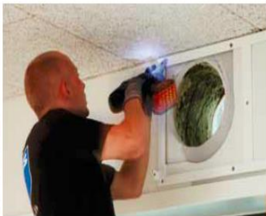
Vaihe 3. Kehyksien kiinnitys seinään
