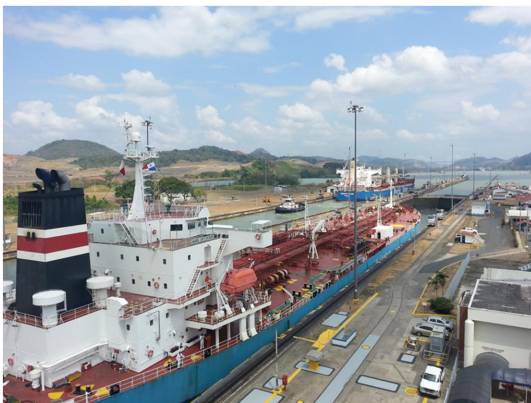
Kuva 1. Mirafloresin sulku (Kirjonen, 2014)
