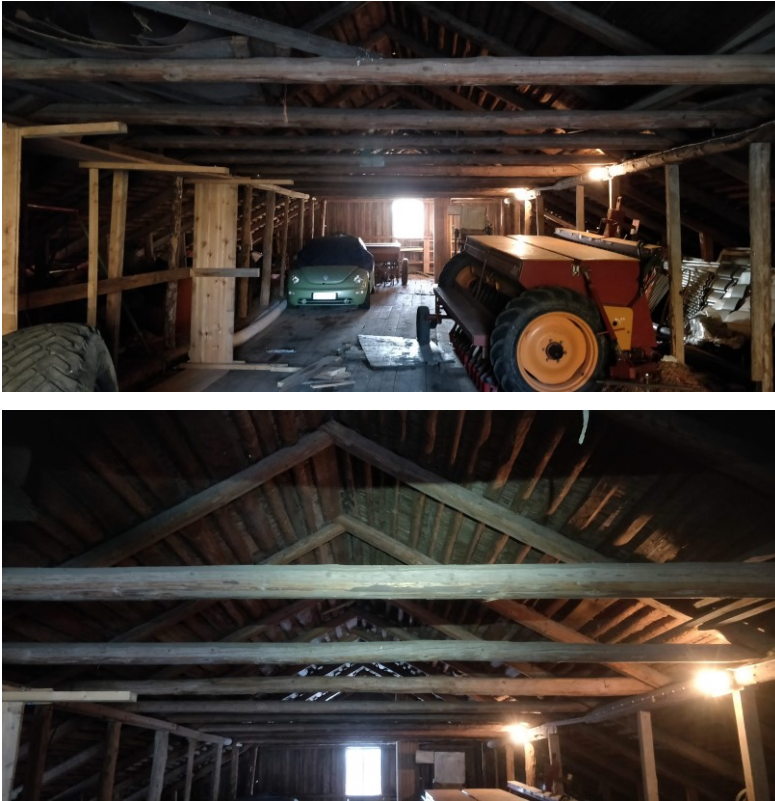
Kuvio 20 Kattorakenteita. (Tiihonen 2023)
