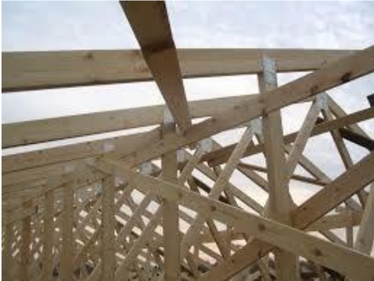
KUVA 4. Esimerkki kattotuolien tuennasta (8)
