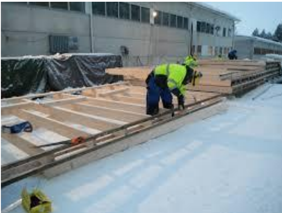
KUVA 2. Seinäelementin valmistus ulkona (7)
