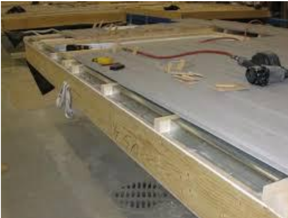
KUVA 1. Seinäelementin valmistus hallissa
