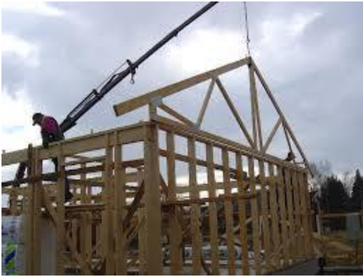
KUVA 3. Esimerkki kattotuolien asennuksesta
