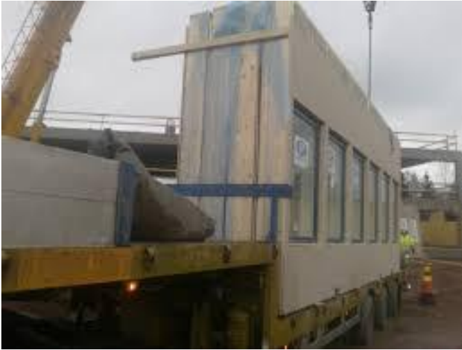
KUVA 7. Esimerkki elementtien kuljetuksesta (12)
