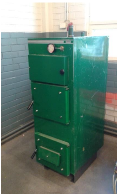
Kuva 2. Jäspi YPV 40 puukattila
