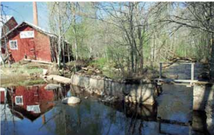
KUVA 38. Karjalankosken pato Karjalankylässä. Joesta otetaan kasteluvettä kesäaikaan, jolloin padon settilankut estävät kalojen vapaan liikkumisen. Kuva: Teemu Koski.
