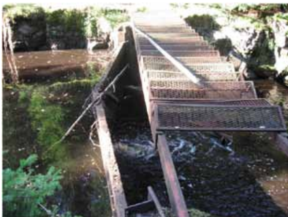
KUVA 39. Mikolan pato. Padoon settilankut on kiilattu toisiaan vasten siten, että veden paine pitää rakennelman tiiviinä. Patoa ei ilmeisesti säädellä. Kuva: Jonna Tähtinen.
