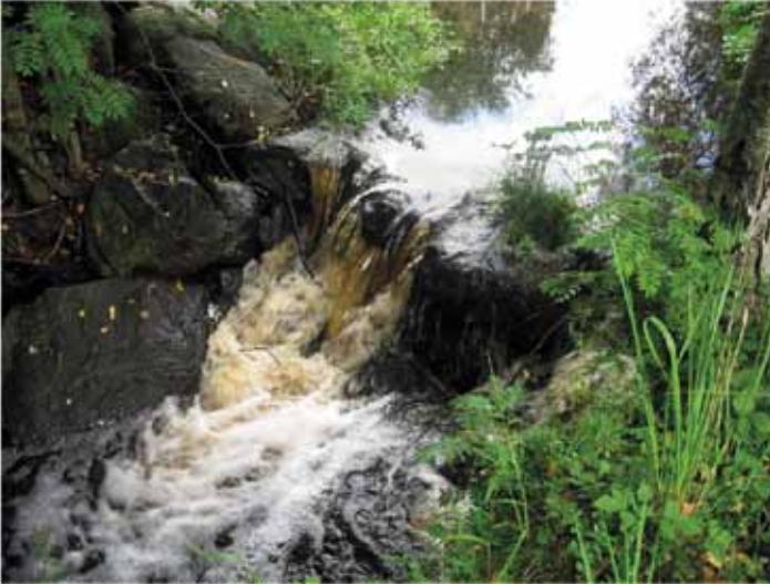
KUVA 42. Joenperänojassa on kivistä tehty pohjapato. Kuva: Jonna Tähtinen.
