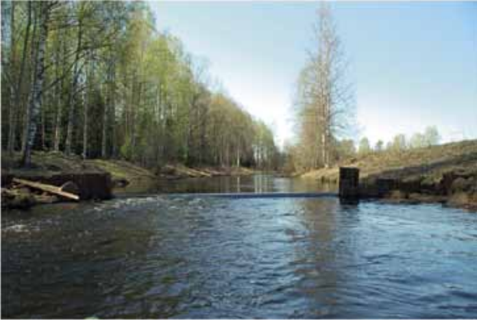
KUVA 36. Koverankoukun pohjapato. Kuva on otettu 10.5.2011, jolloin joen vesi oli melko korkealla. Padon alivirtaaman aikaisesta pudotuskorkeudesta ei ole tietoa. Kuva: Teemu Koski.
