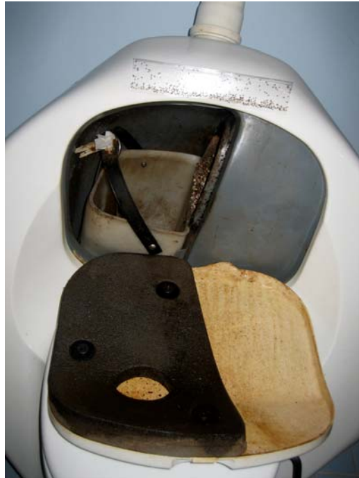
Kuva 4. Kohteen kuusi (6) Naurum-istuimen rumpukomposti. /8/
