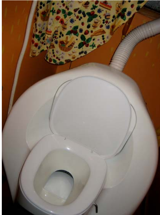
Kuva 3. Kohteen viisi (5) kuivakäymälä. /8/
