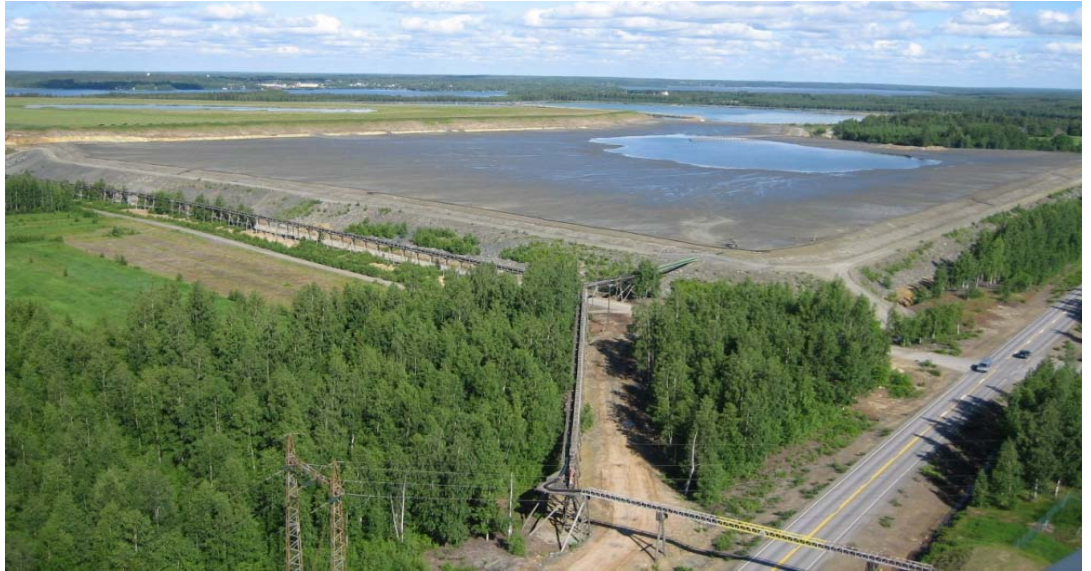
Kuva 5. Pyhäsalmi Mine Oy:n rikastehiekka-altaat. (Kuva: Tarja Tikkanen)
