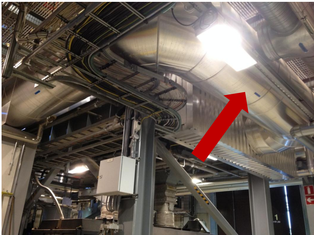
Kuva 14. Höyryluvon paikka ennen ilmakaappia.
