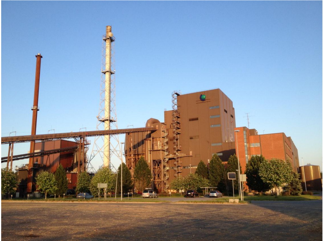
Kuva 1. Joensuun voimalaitos sekä vasemmalla Kontiosuon lämpökeskus.
