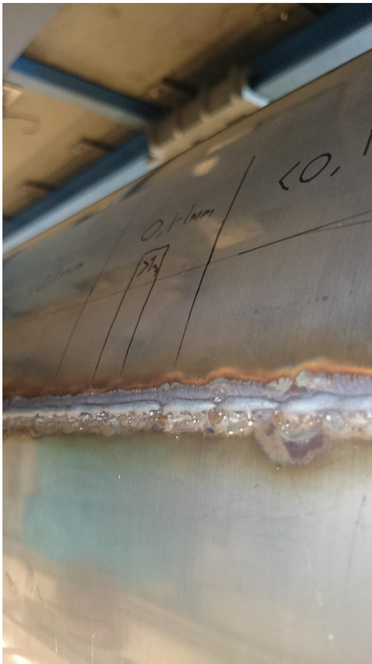
Kuva 35. Kyljen hitsi lähempää tarkasteltuna. (Salmi 2010-06-13)
