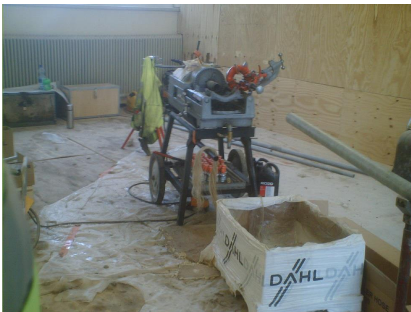
Kuva 3. Aliurakoitsijan suojaama työtila (Pitkänen 2014-04-22).
