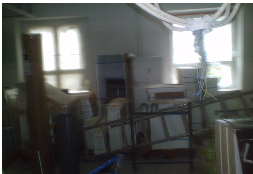
Kuva 11. Varastoitua työmaataravaa. (Pitkänen, 2014-04-22).
