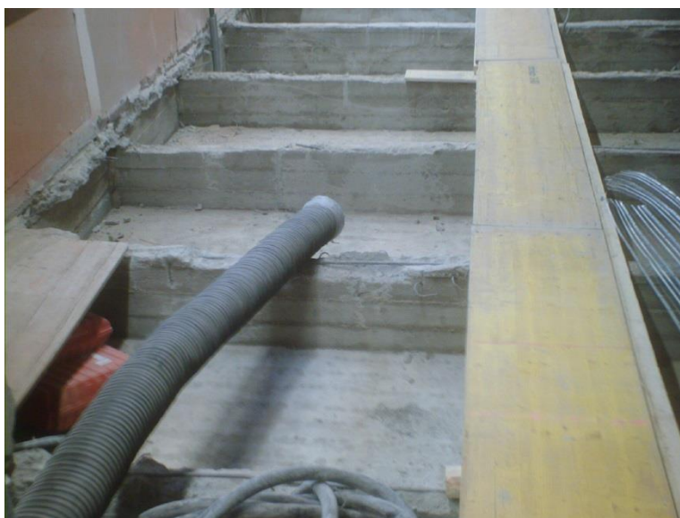
Kuva 9. Purujen imurointi (Pitkänen, 2014-04-22).
