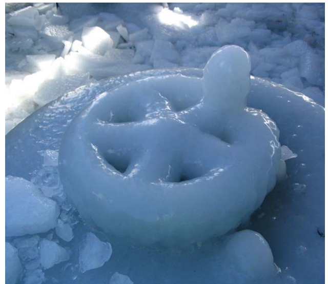
Kuva 67. Ilmankosteuden kerryttämää jäätä manusuukun päällä (Eini Hakala 2005).
