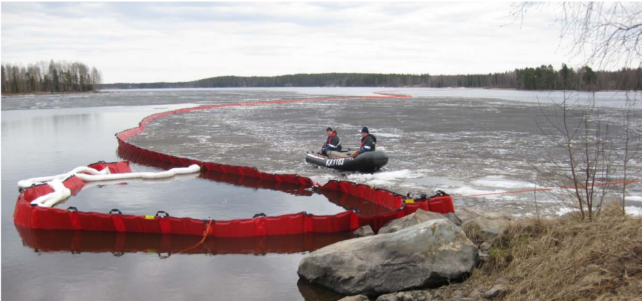
Kuva 14. Kajaanin Kulunnanpuron öljyvahingossa puomitusta seurattiin päivittäin jäidenlähdön aikaan (Kainuun pelastuslaitos 2012).
