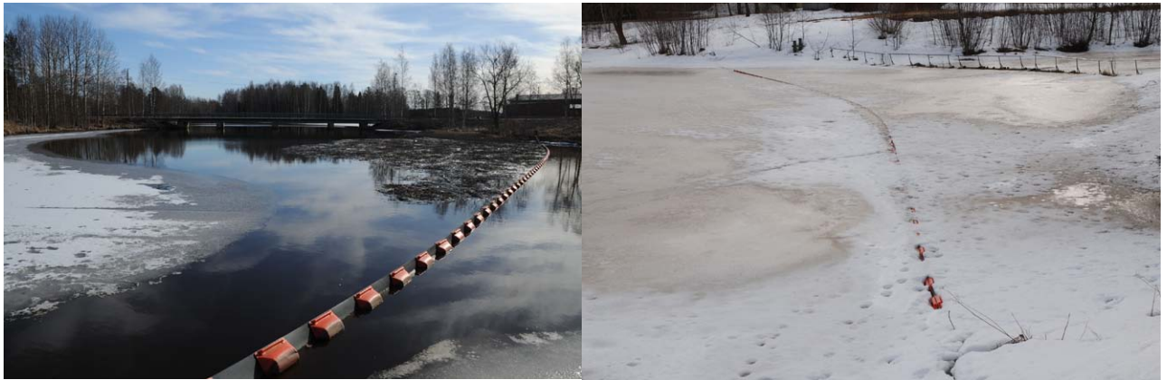
Kuva 24. Läpi vuoden Kurikanjoessa pidettävää puomitusta kiinteäkellukkeisella aitapuomilla (Juha Muhonen 2012 ja 2014).
