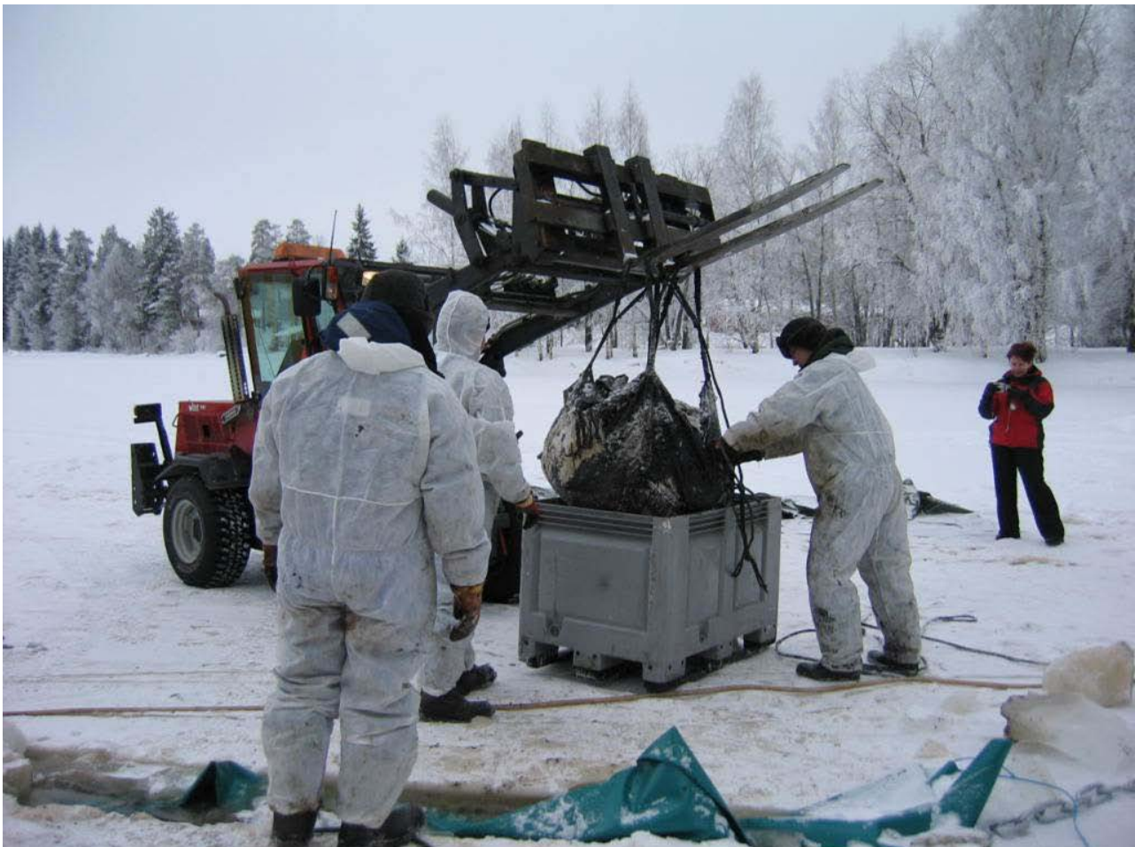
Kuva 65. Öljyisten nuottien pakkaamista Kelloniemen öljyvahingossa. Kuvan alalaidassa näkyy ensimmäinen suojapuumi (Pohjois-Savon ELY-keskus).
