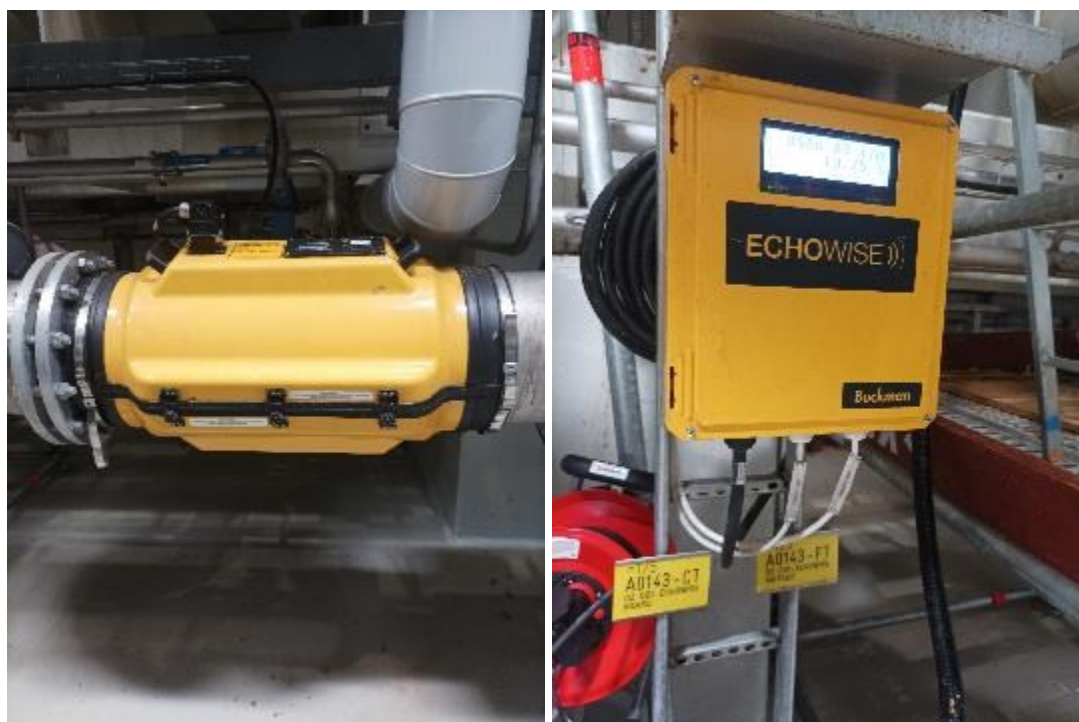
Kuva 11. Echowise-anturi vasemmalla ja mittausyksikkö oikealla
