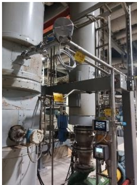
Kuva 50. Prosessirefraktometri happivaiheen jälkeisen DD-1 pesurin palautussuodos
