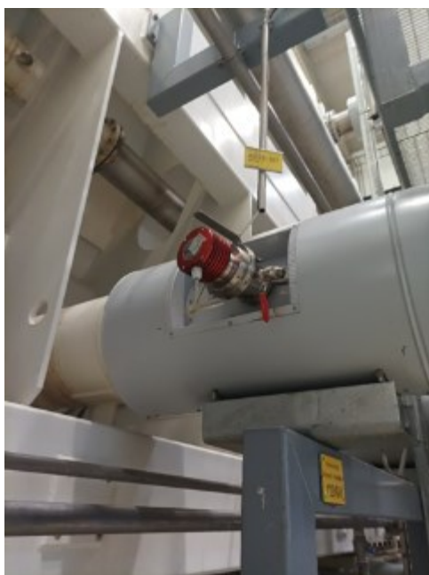
Kuva 43. Keittimen jälkeisen DD-1 pesurin syöttömassan prosessirefraktometri
