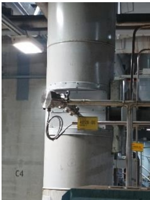
Kuva 49. Prosessirefraktometri keittimen jälkeisen DD-1 pesurin palautussuodos
