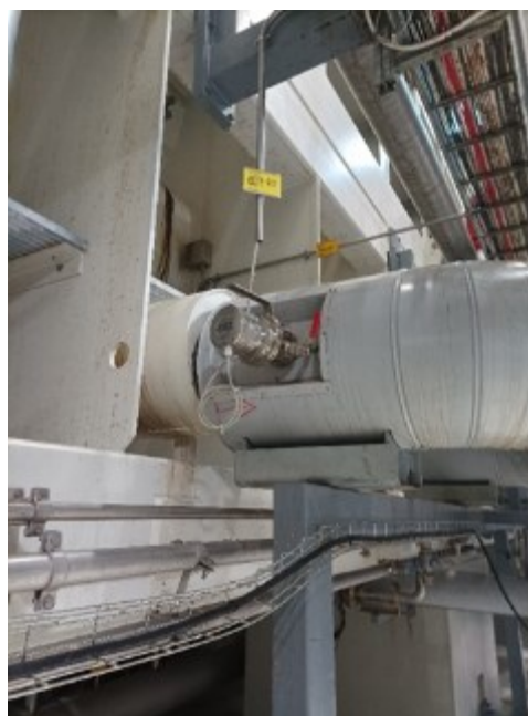
Kuva 44. Happivaiheen jälkeisen DD-1 pesurin syöttömassan prosessirefraktometri
