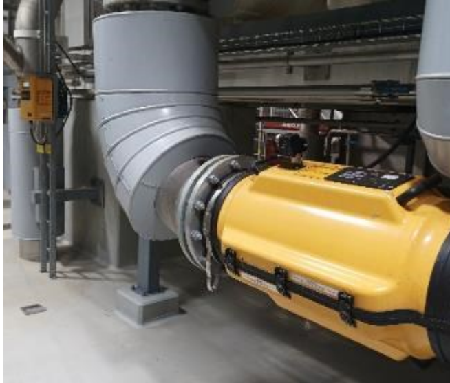
Kuva 37. Echowise-prosessissa happivaiheen jälkeisessä DD1-pesurin syöttölinjassa
