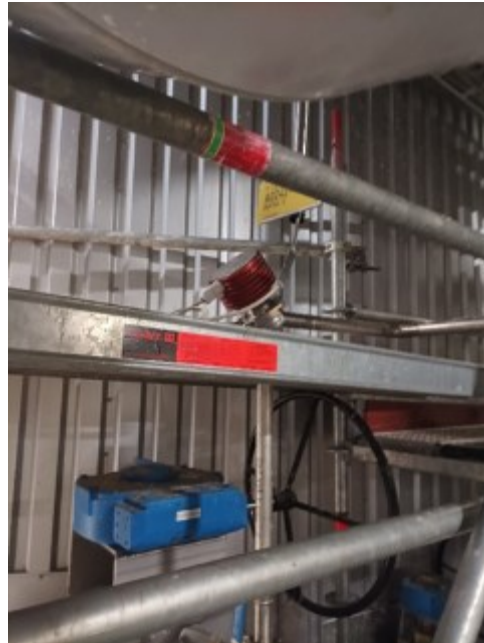
Kuva 44. Prosessirefraktometri happivaiheen jälkeisen DD-1 pesurin pesuneste pesupuristimelta
