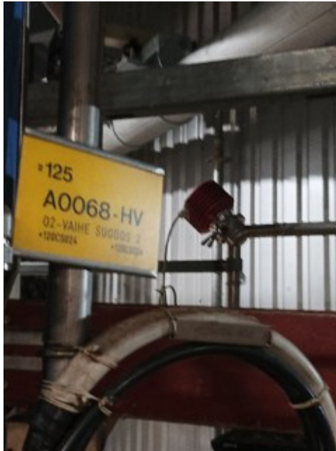
Kuva 43. Prosessirefraktometri keittimen jälkeisen DD-1 pesurin puhtaampi pesuneste
