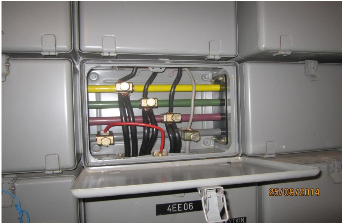
Kuva 2. Syöttökaapelin kytkentä virtakiskoihin.
