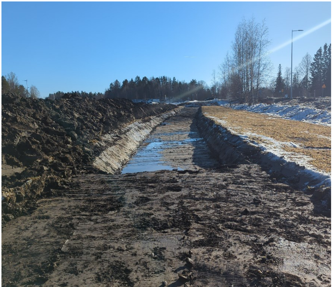
Kuva 2, Maanleikkaus alimpaan yhdistelmäpintaan kevyenliikenteen väylällä. (3)
