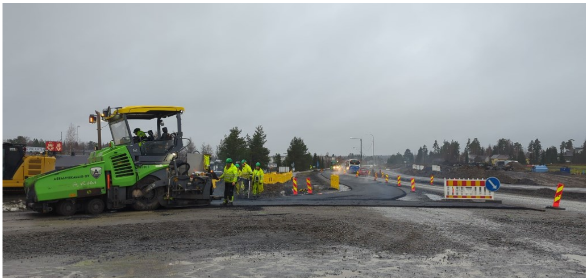
Kuva 4, Kuljuntien kiertoliittymään ABK 31 kerroksen levitys. (19)
